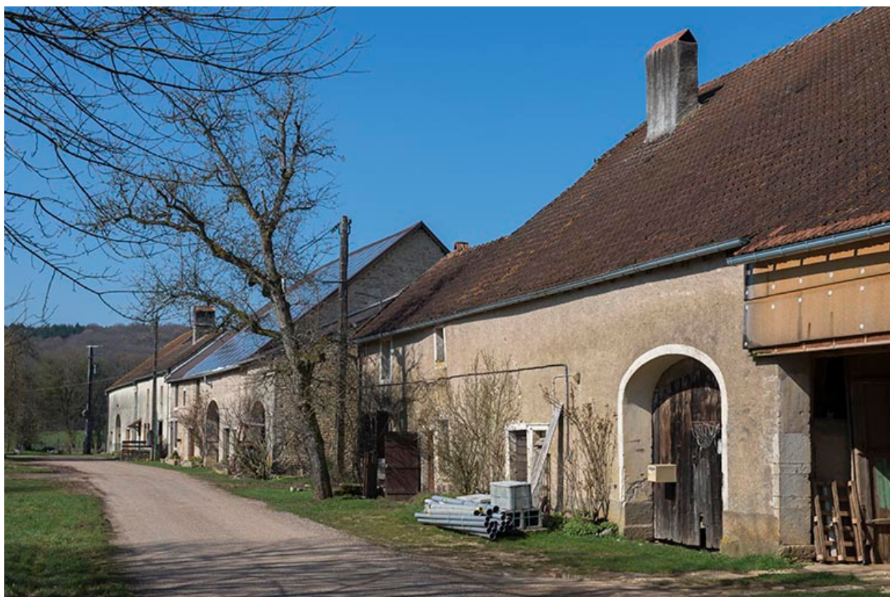
Fermes situés au hameau des Arpents.
