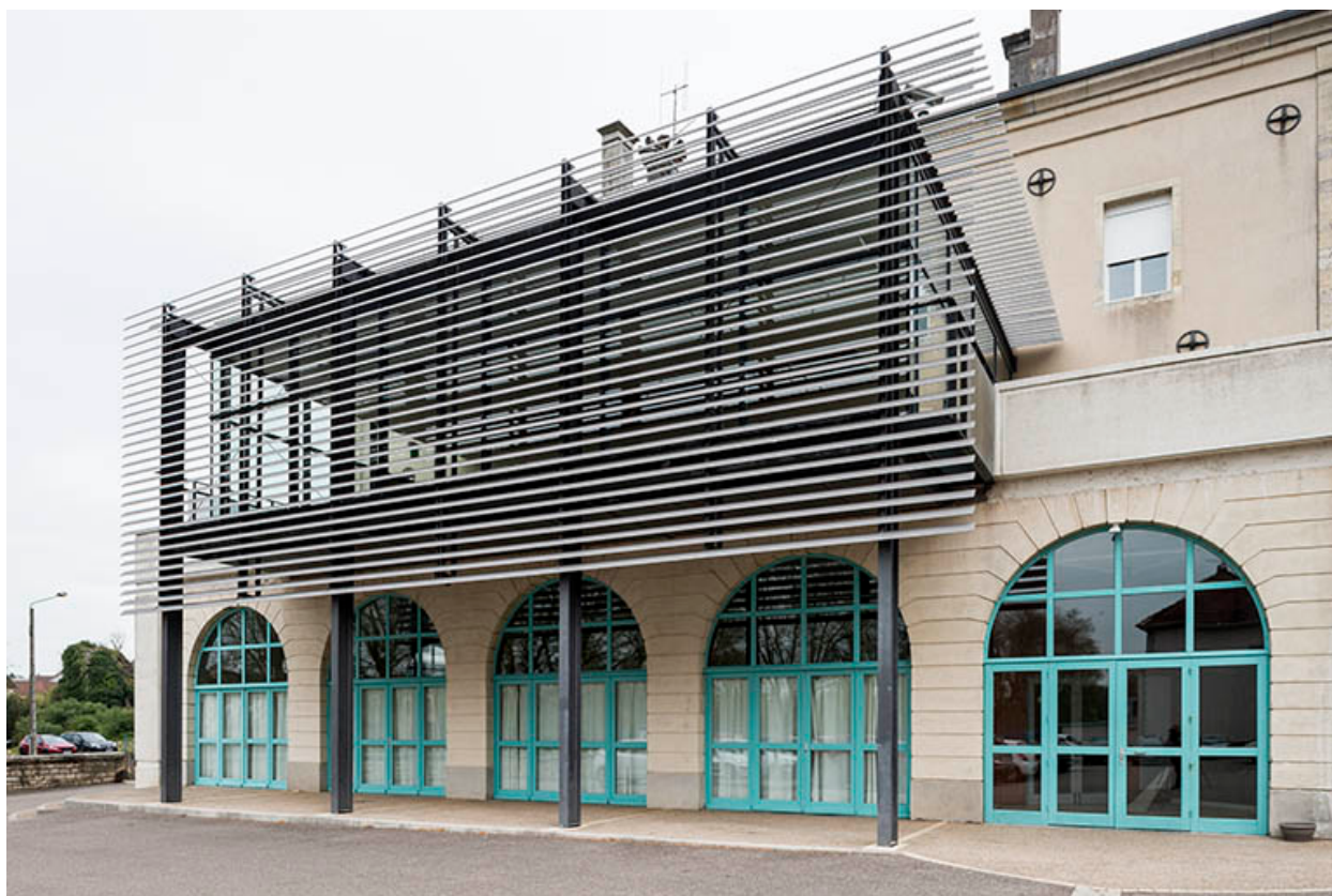
Façade postérieure de l'hôtel de ville.
