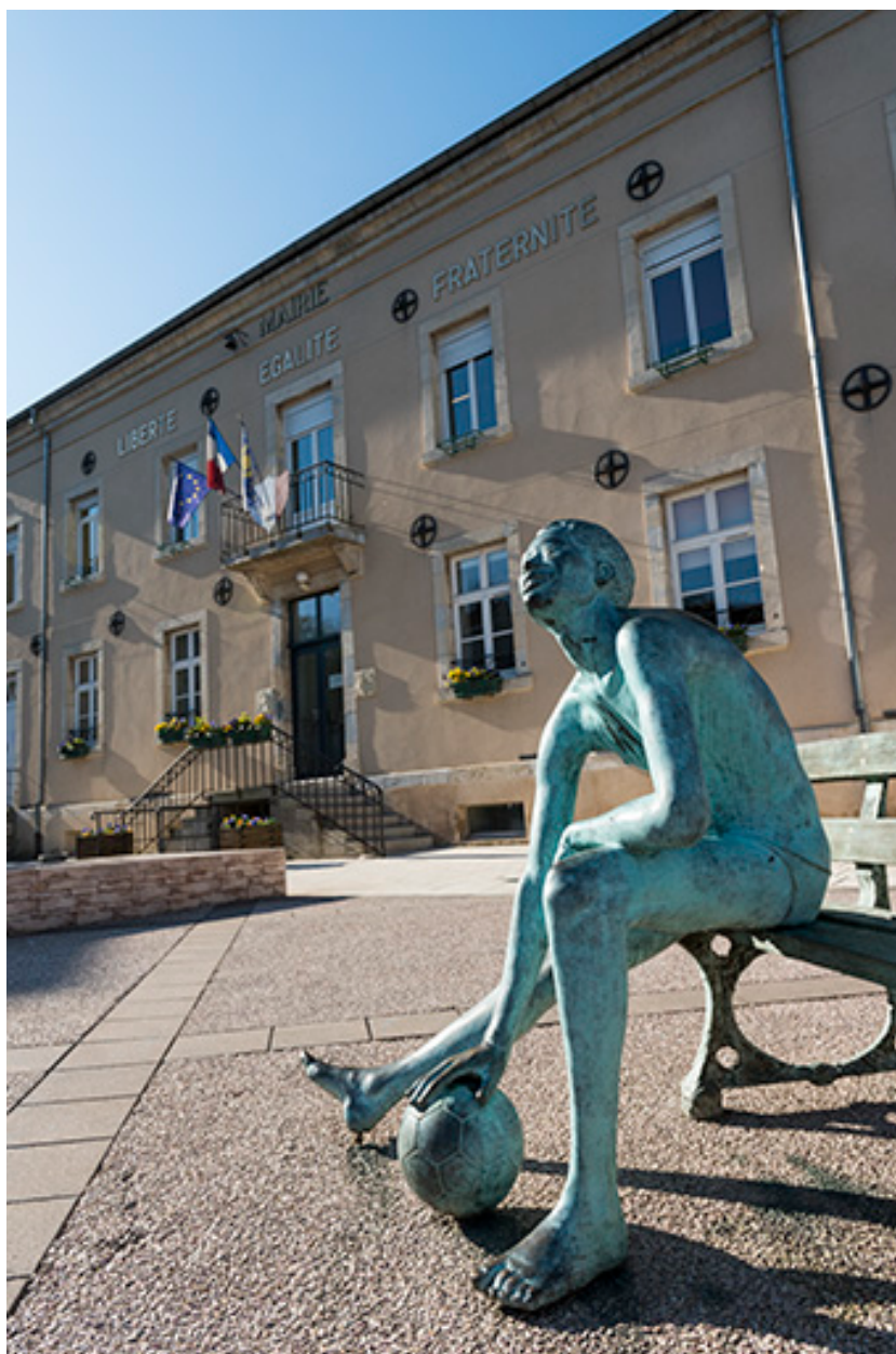
Façade principale de la mairie.
