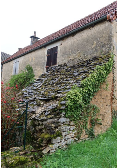
Vue de la remise, adossée à la ferme. Phot. Baptiste Quost IVR26_20242100031NUC2A
