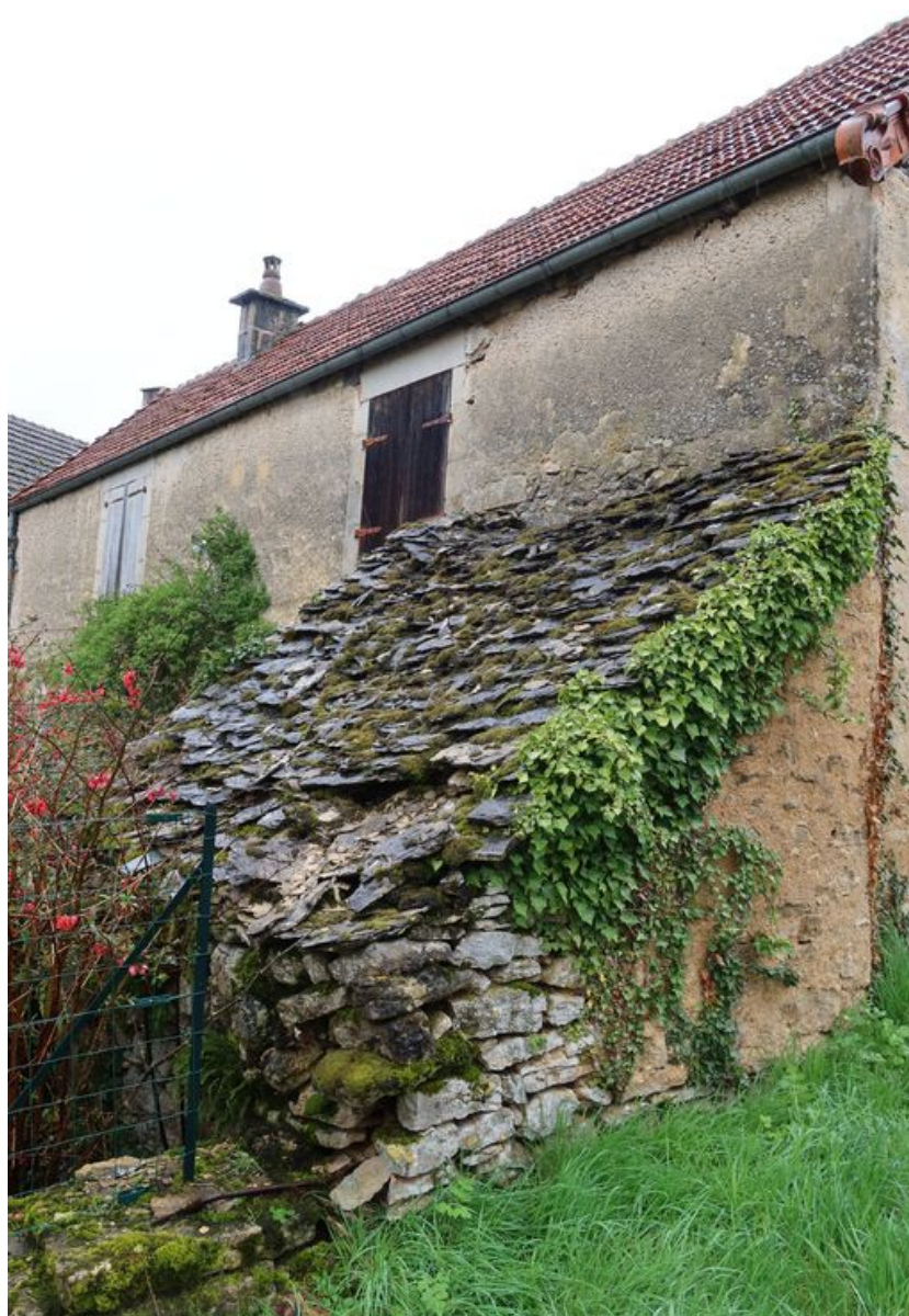
Vue de la remise, adossée à la ferme.
