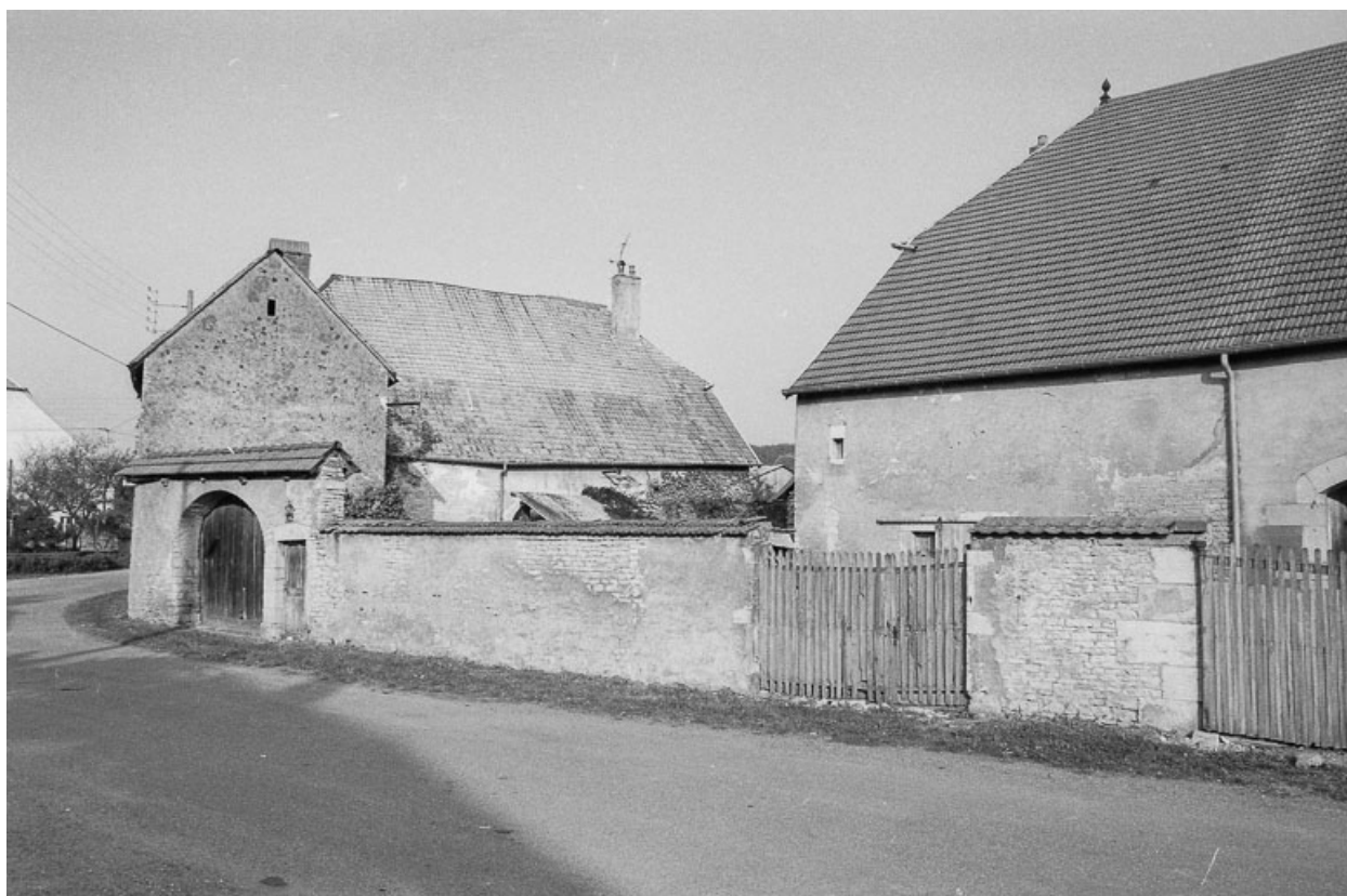
Façades sur rue.
