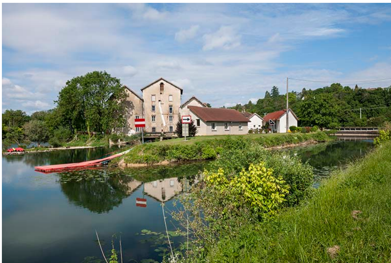
Vue d'ensemble depuis l'est.
