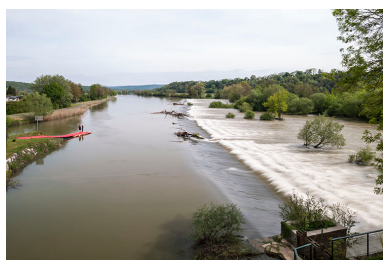
Le barrage, depuis l'ouest. Phot. Jérôme Mongreville IVR43_20152501286NUC4A
