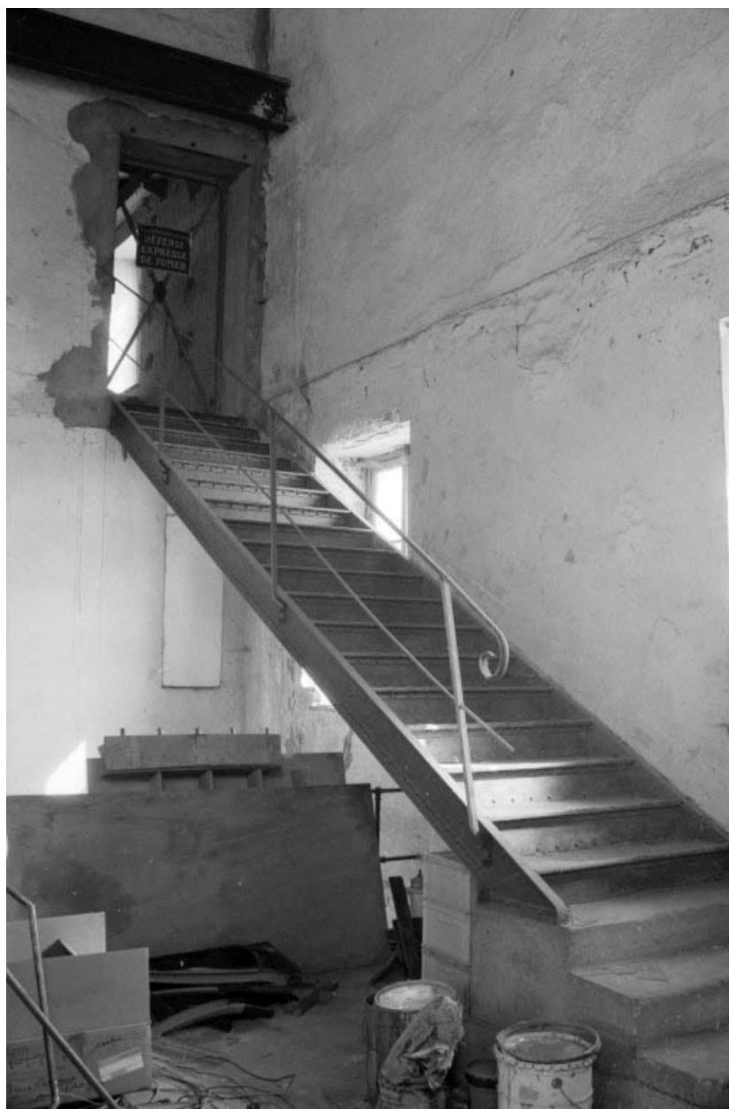
Salle des machines à vapeur (b3) : escalier.
