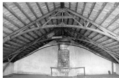
Ancien atelier de fabrication (b2), étage en surcroît : détail de la charpente et mur pignon ouest. Phot. Laurent Poupard IVR43_19883900364Z
