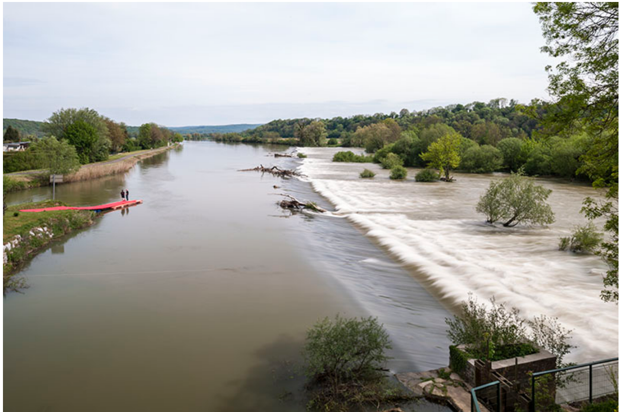
Le barrage, depuis l'ouest.
