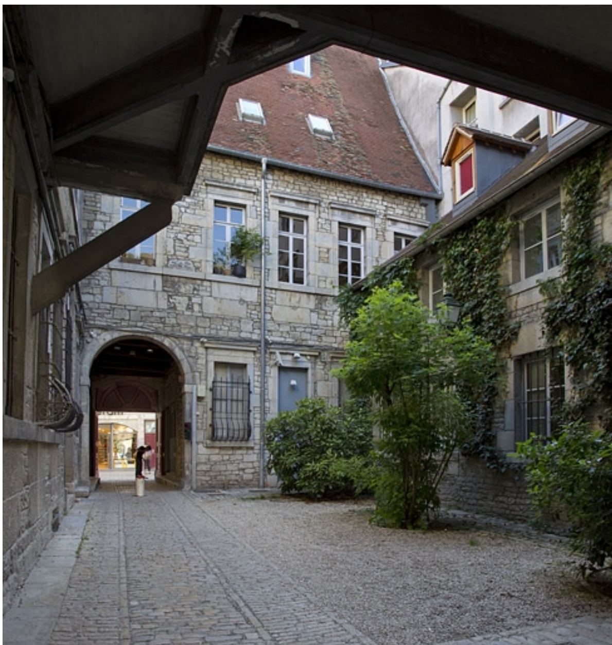
Logis principal : aile sur rue, façade postérieure.
