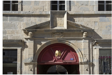
Logis principal, portail d'entrée : détail du fronton interrompu à tabernacle. Phot. Yves Sancey IVR43_20112500923NUC2A
