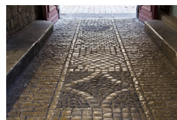
Premier passage cocher : décor du sol
