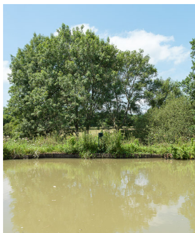
Vue du déversoir.
