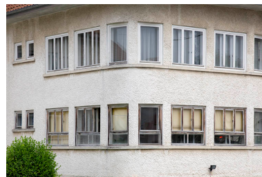
Fenêtres du corps de bâtiment de 1965. Phot. Yves Sancey IVR43_20122502295NUC2A
