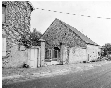
Partie agricole. Phot. Dominique Dominguez IVR43_19807000245X
