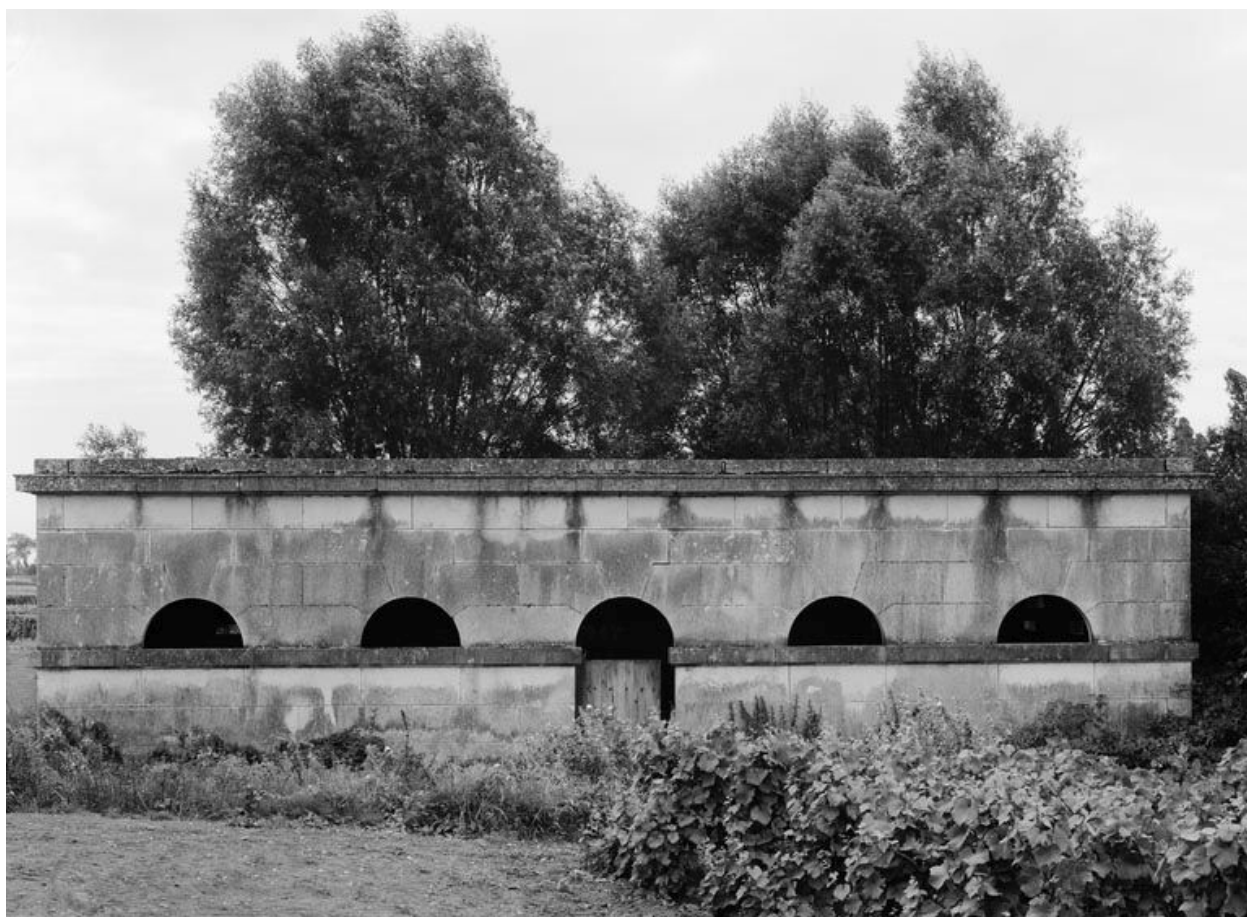
Vue de la façade antérieure du lavoir.
