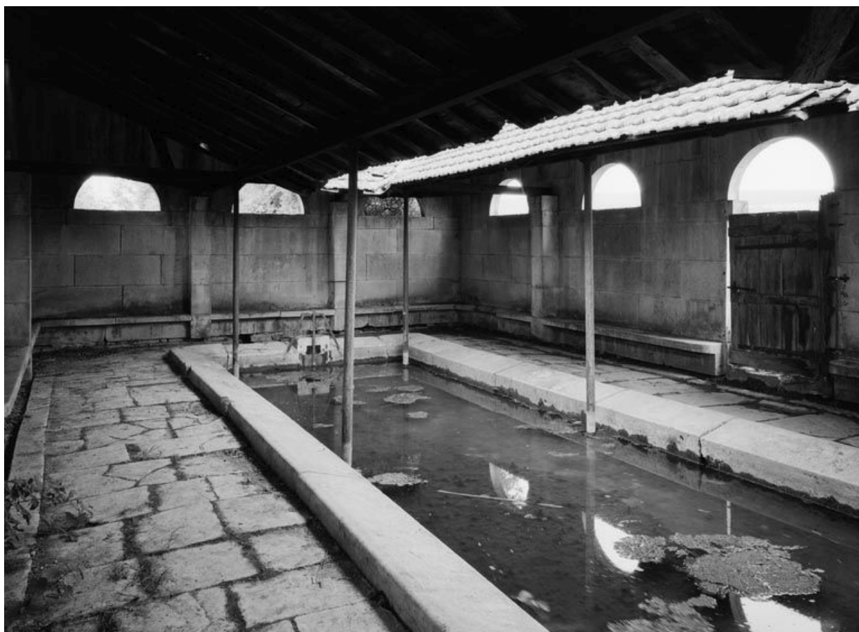
Vue intérieure du lavoir.
