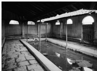
Vue intérieure du lavoir. Phot. Jean-Luc Duthu IVR26_19792101197V
