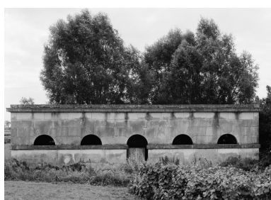
Vue de la façade antérieure du lavoir. Phot. Jean-Luc Duthu IVR26_19792101193V
