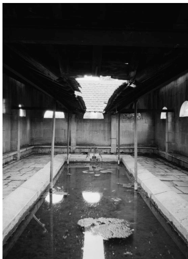
Vue intérieure du lavoir. Phot. Jean-Luc Duthu IVR26_19792101198V
