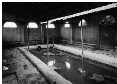
Vue intérieure du lavoir. Phot. Jean-Luc Duthu IVR26_19792101196V
