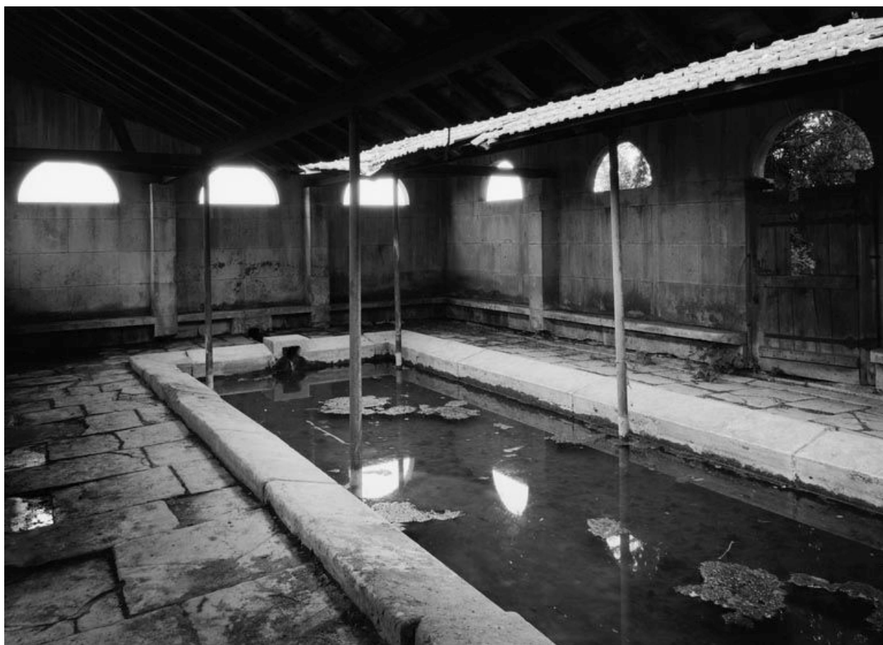
Vue intérieure du lavoir.
