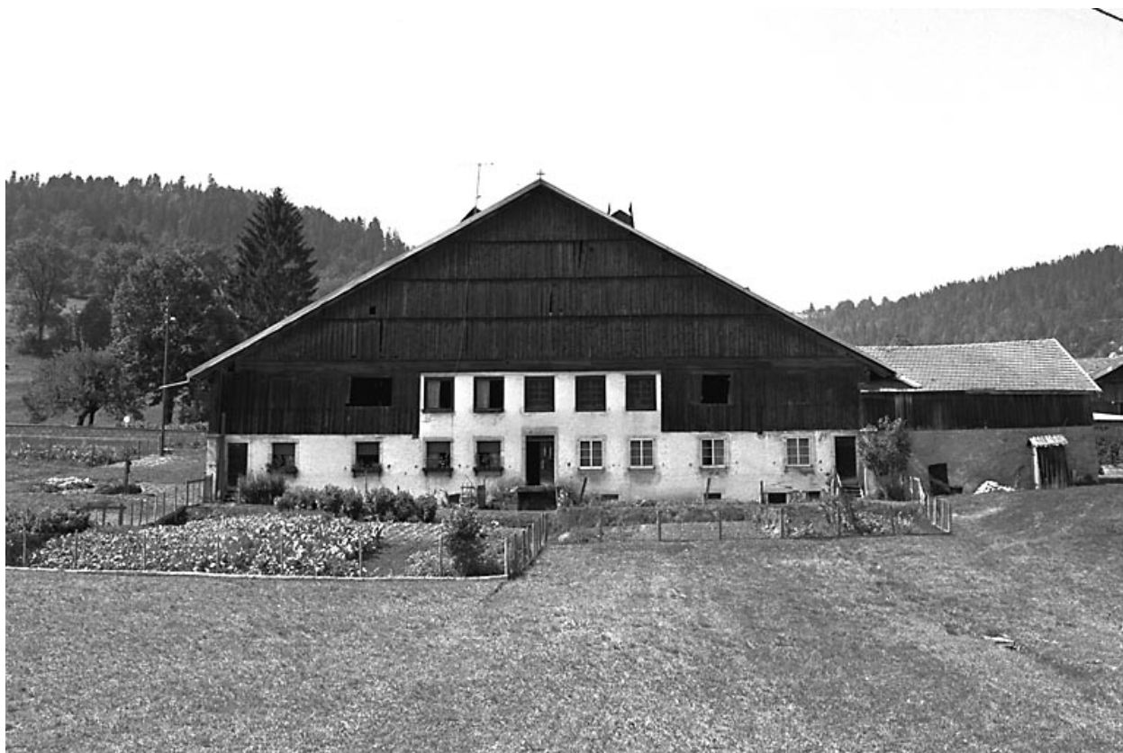
Grand'Combe Châteleu, ferme 2 située au lieu-dit Les Cordiers : façade postérieure.
