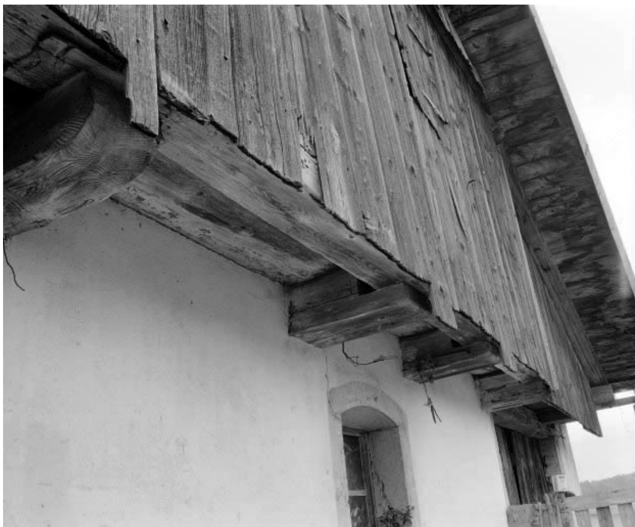
Les Combes : ferme située au lieu-dit La Motte, surplomb de la "lambrechure".
