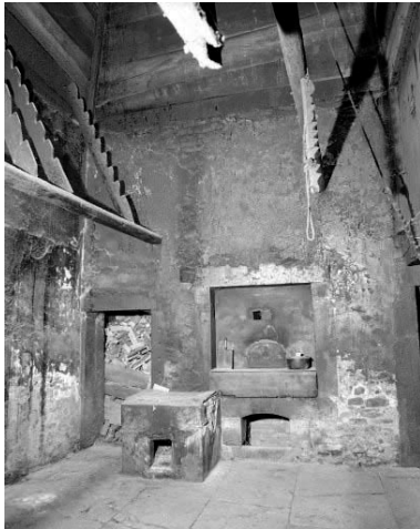
Les Gras, ferme 1 située au lieu-dit Le Dessus de la Fin : base du grand "tué" et bûcher.
