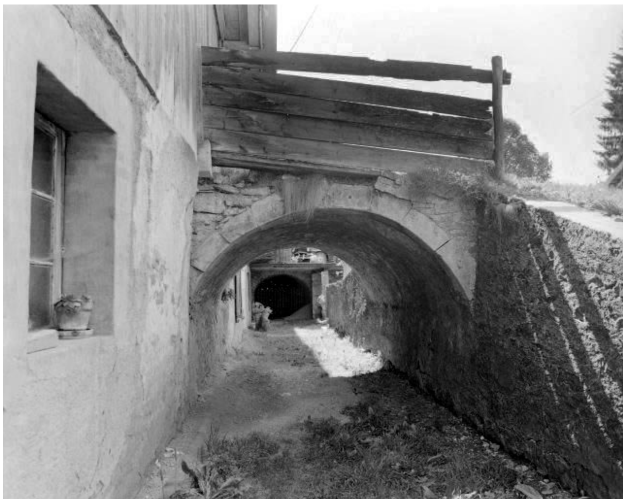
Grand'Combe Château, ferme 2 située au lieu-dit Les Cordiers : pont de grange sur la façade antérieure.
