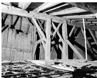
Grand'Combe-Châteleu, 1ère ferme : fermes de chaprente jumelées, en arrière des "tués".
