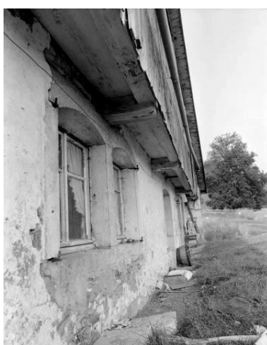
Grand'Combe Châteleu, ferme 3 située au lieu-dit Chauveresche : surplomb de la "lambrechure" antérieure.
