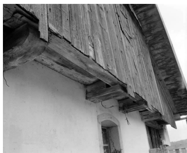
Les Combes : ferme située au lieu-dit La Motte, surplomb de la "lambrechure". Phot. Yves Sancey IVR43_19772500355X
