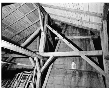
Grand'Combe-Châteleu, 1ère ferme : ferme de charpente et hottes des "tués".
