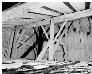
Grand'Combe-Châteleu, 1ère ferme : fermes de la charpente postérieure. Phot. Yves Sancey IVR43_19772500333X
