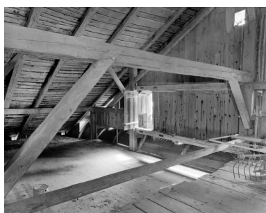
Grand'Combe-Châteleu, ferme 4 située au lieu-dit Cornabey : charpente et "lambrechure" intérieure à surplomb cintré. Phot. Yves Sancey IVR43_19772500319X
