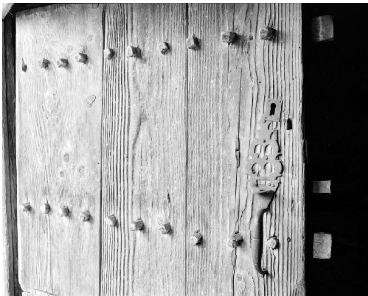
Grand'Combe-Château, 1ère ferme : poignée de la porte de grange gauche.
