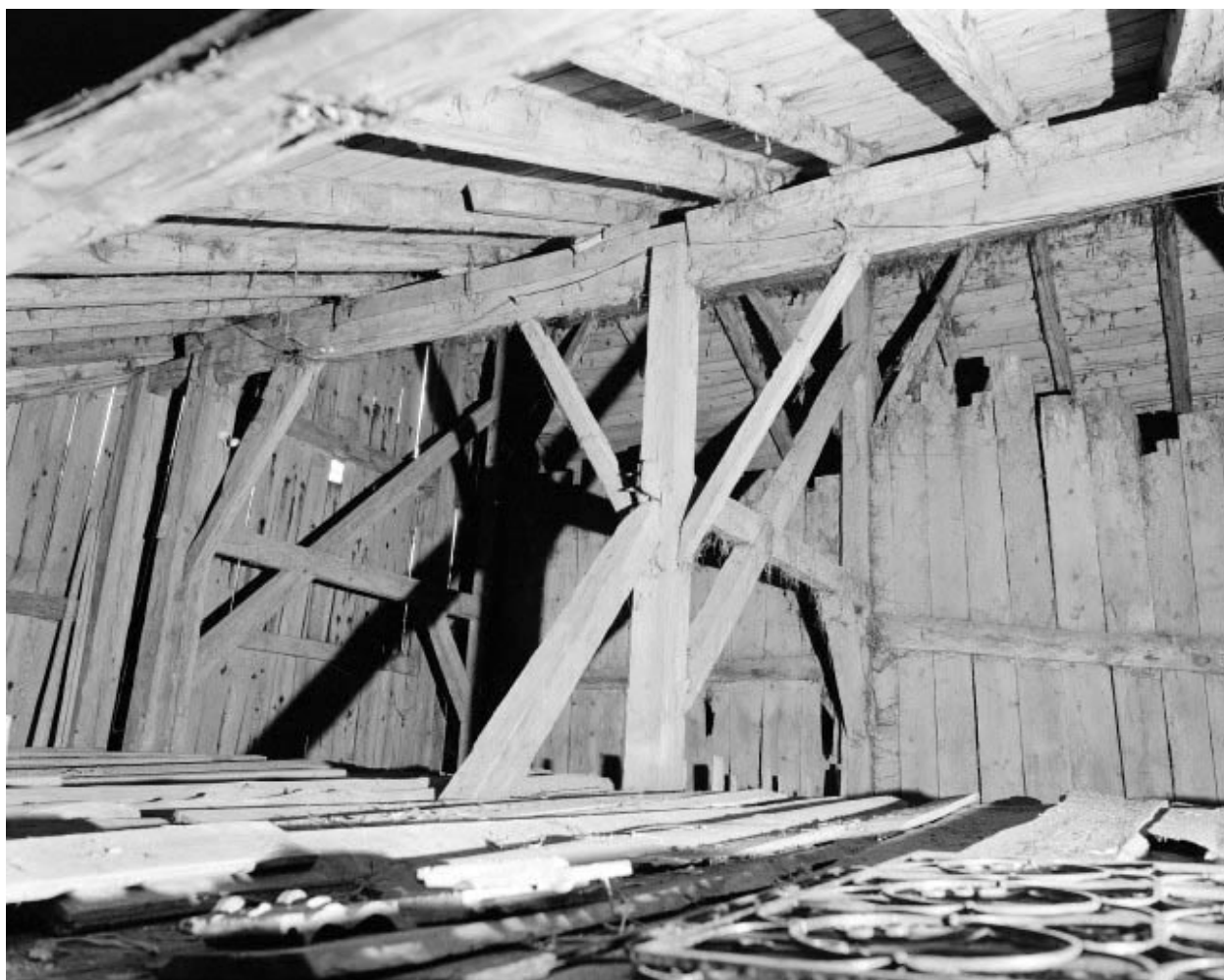
Grand'Combe-Château, 1ère ferme : fermes de la charpente postérieure.
