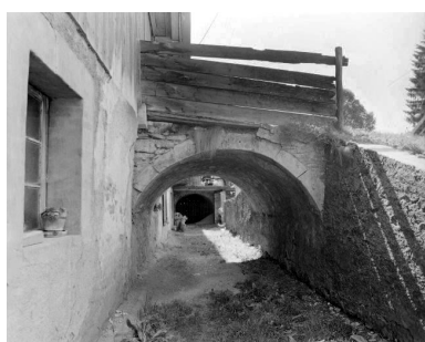
Grand'Combe Châteleu, ferme 2 située au lieu-dit Les Cordiers : pont de grange sur la façade antérieure. Phot. Dominique Humbert IVR43_19762500607X
