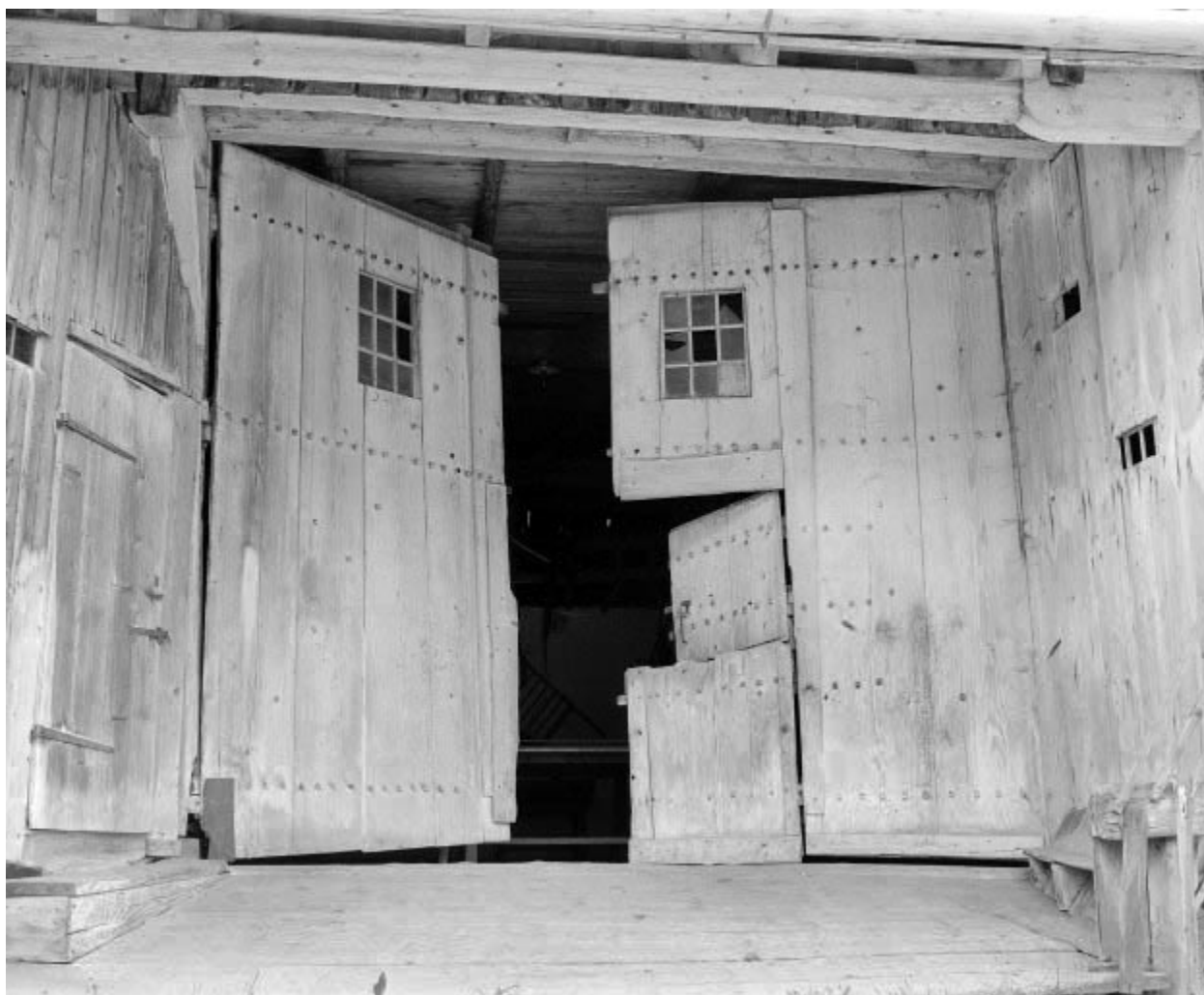
Grand'Combe-Châteleu, 1ère ferme : porte de grange droite ouverte.
