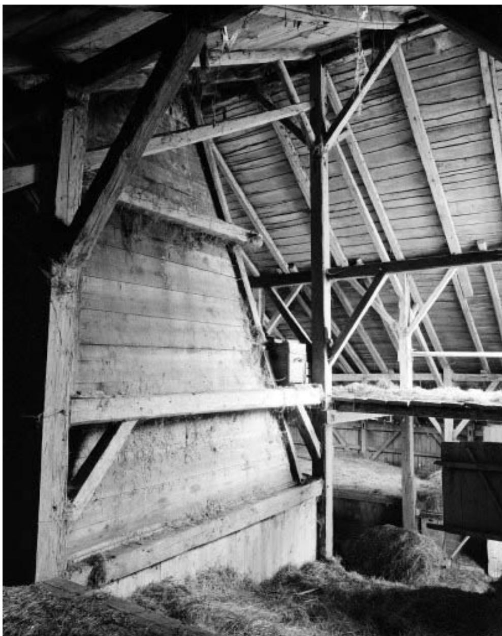
Grand'Combe-Châteleu, ferme 4 située au lieu-dit Cornabey : la charpente et le "tué".
