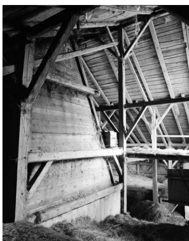
Grand'Combe-Châteleu, ferme 4 située au lieu-dit Cornabey : la charpente et le "tué". Phot. Yves Sancey IVR43_19772500320X
