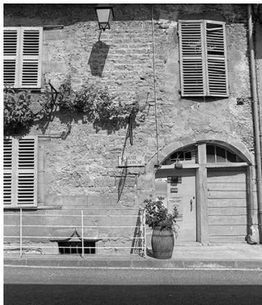
Détail de la façade antérieure : l'entrée. Phot. Yves Sancey IVR43_19802500980X
