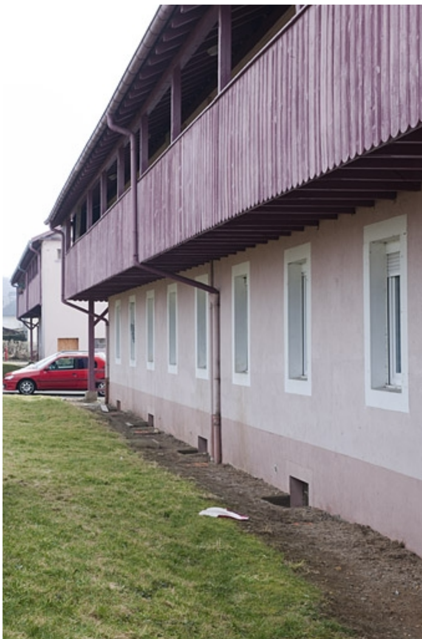
Façade postérieure d'un immeuble d'habitation.
