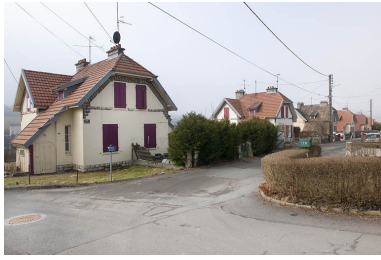
Maisons jumelées impasse Bellevue. Phot. Jérôme Mongreville IVR43_20122500135NUC4A
