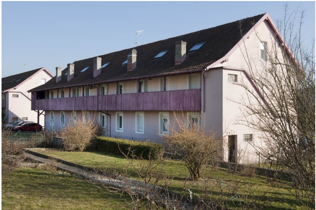
Immeuble d'habitation vu de trois quarts arrière..
