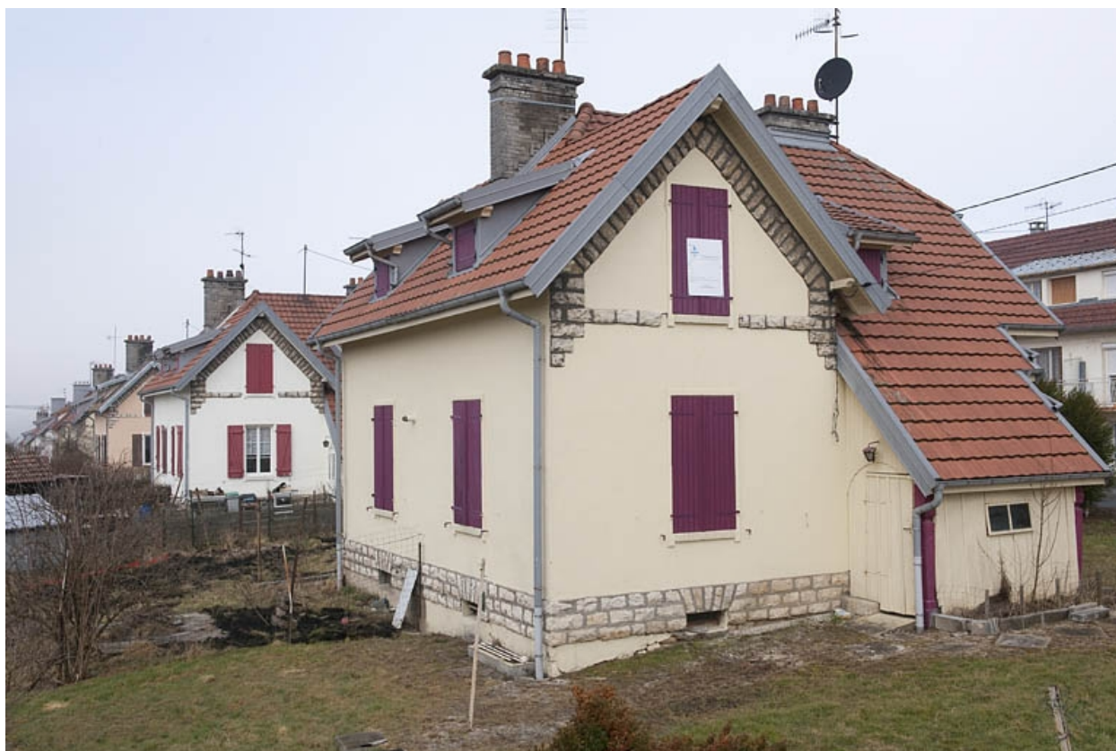
Façades sud des maisons jumelées impasse Bellevue.
