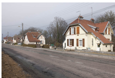
Maisons jumelées route de Méziré. Phot. Jérôme Mongreville IVR43_20122500136NUC4A
