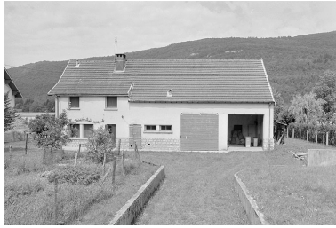
Façade antérieure. Phot. Jérôme Mongreville IVR43_19973900890X
