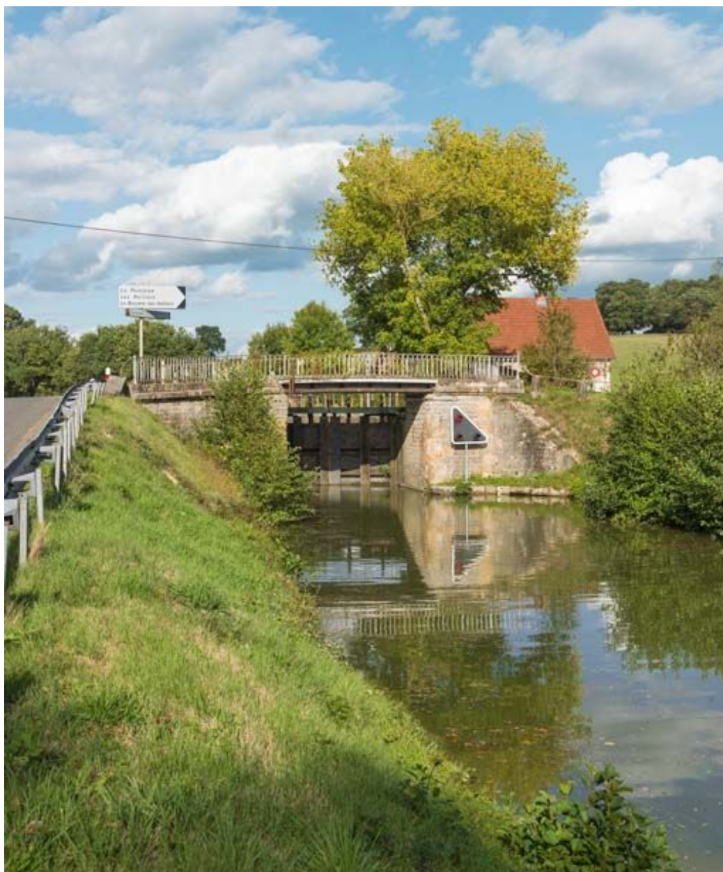
Vue d'ensemble du pont.
