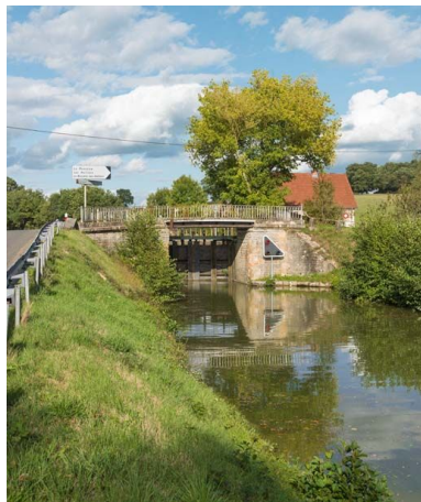
Vue d'ensemble du pont.
