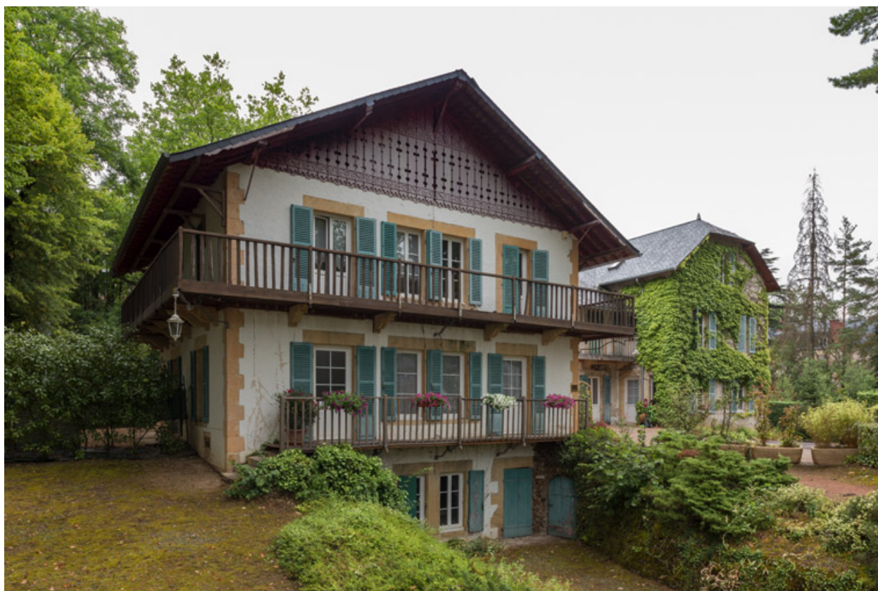
Façade du corps principal, vue de trois-quarts.
