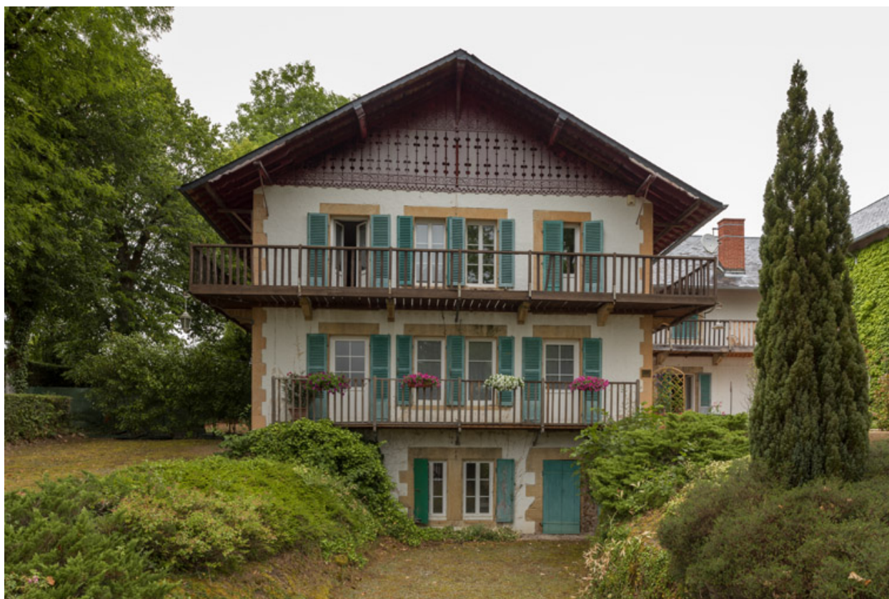
Façade du corps principal, vue de face.
