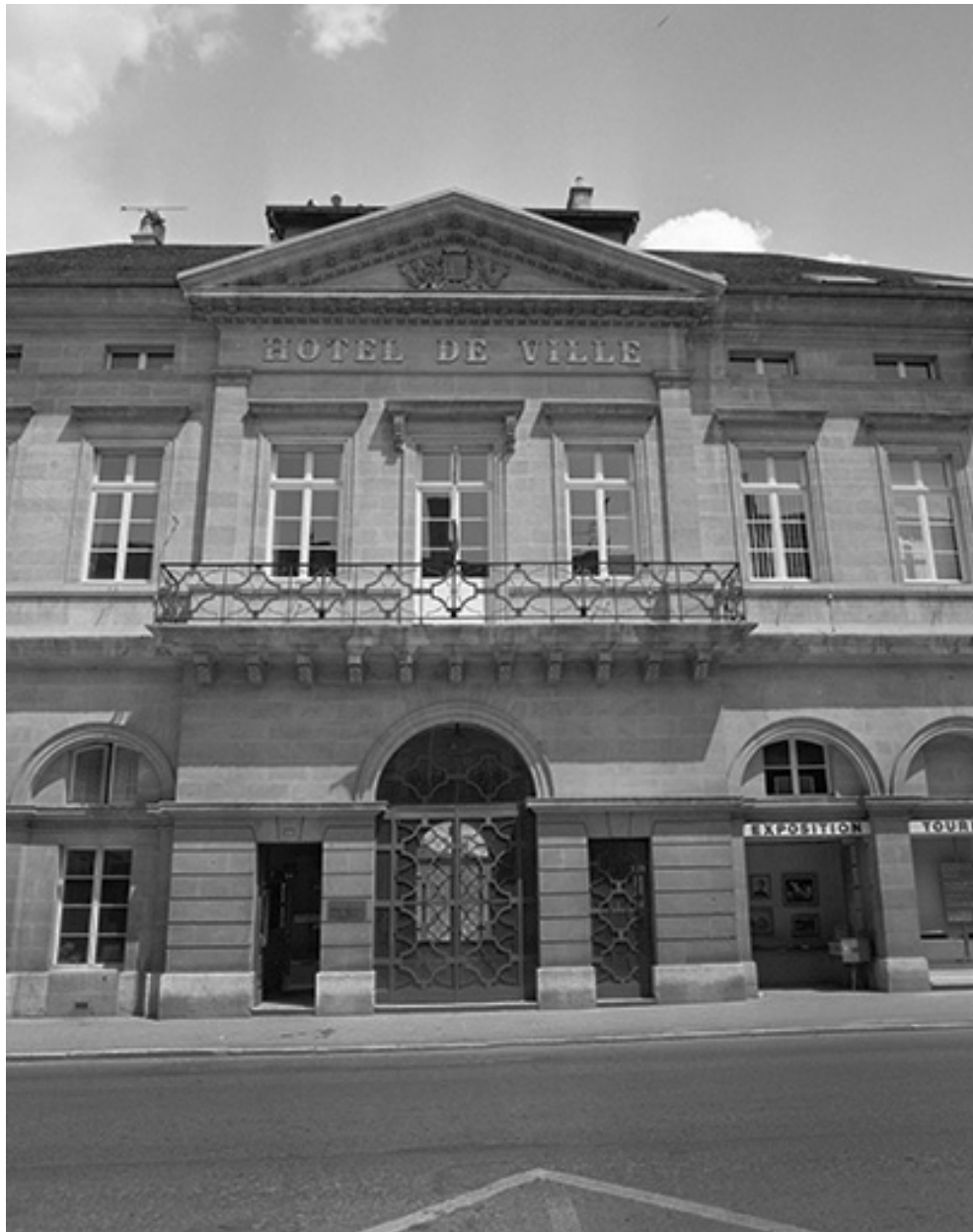
Façade antérieure, partie centrale.
