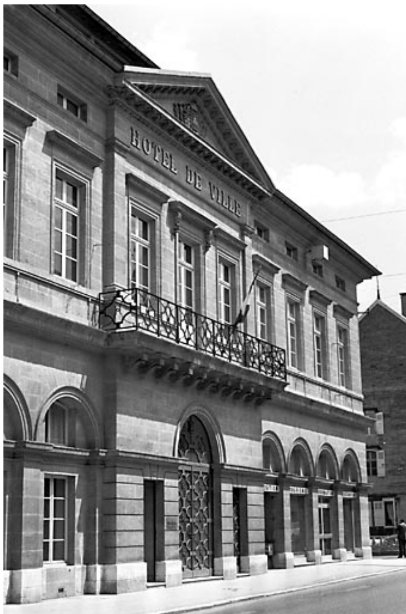
Façade sur la rue de la République.
