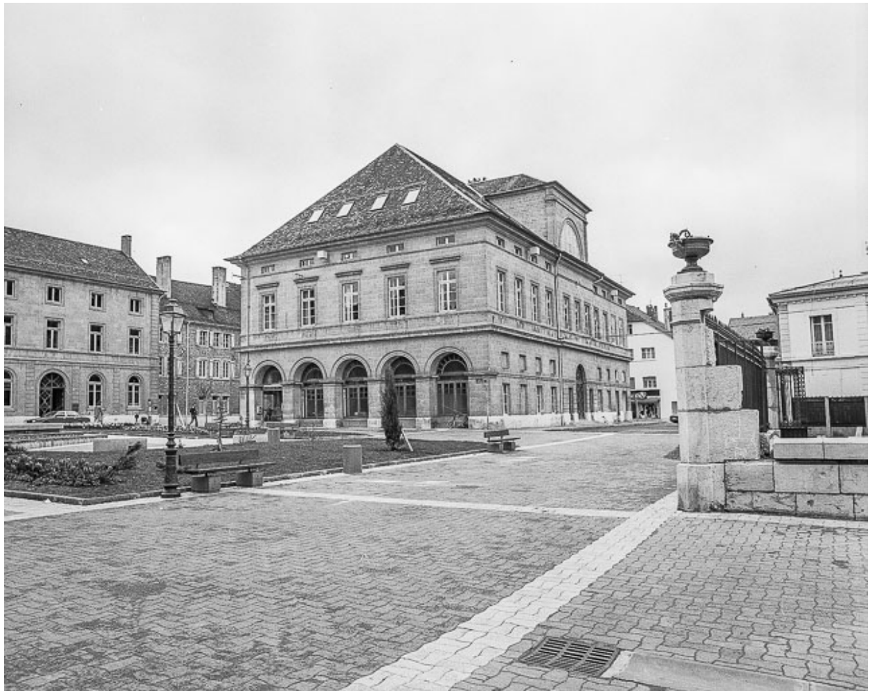
Façade postérieure et façade latérale droite.
