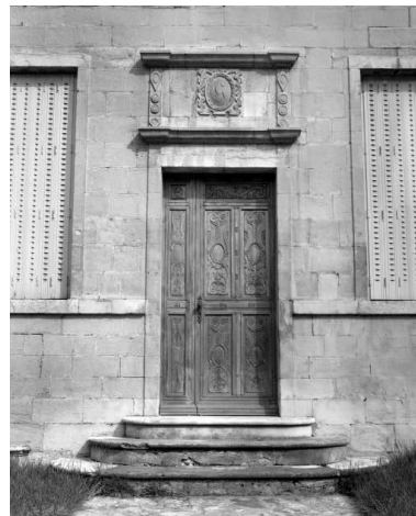
Porte du logis. Phot. Yves Sancey IVR43_19772500026X
