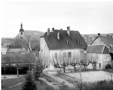
Façade postérieure. Phot. Yves Sancey IVR43_19772500121X
