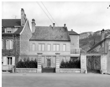
Façade antérieure. Phot. Yves Sancey IVR43_19772500025V
