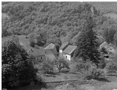
Façade postérieure. Phot. Yves Sancey IVR43_19813900208X
