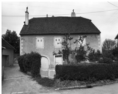
Ferme située rue Saint- Antoine : façade antérieure. Phot. Yves Sancey IVR43_19813900250X
