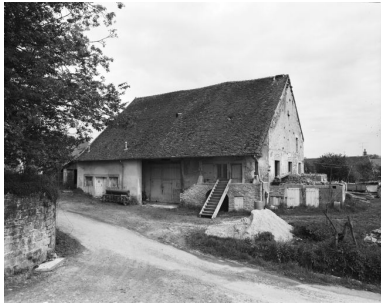
Ferme située rue Alfred Labordère : vue d'ensemble. Phot. Yves Sancey IVR43_19813900249X
