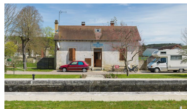
La maison éclusière de face. Phot. Pierre-Marie Barbe-Richaud IVR26_20138900053NUC4AQ
