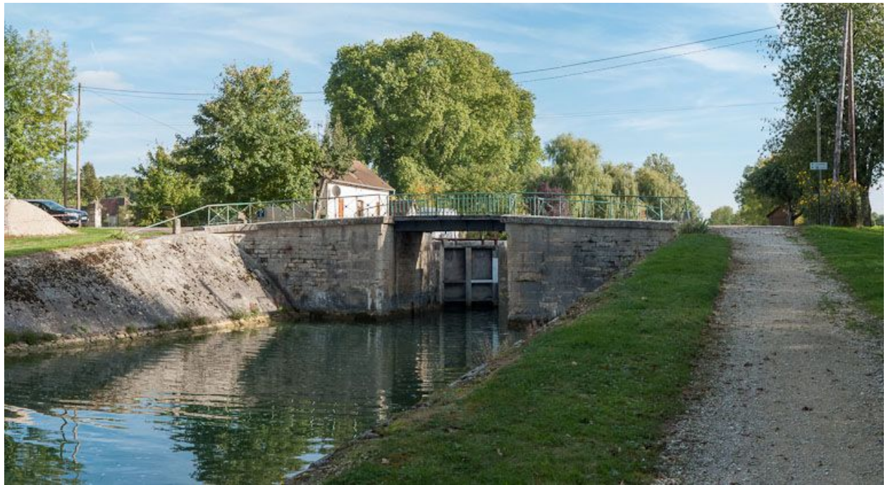
Vue d'ensemble du site, prise d'aval.
