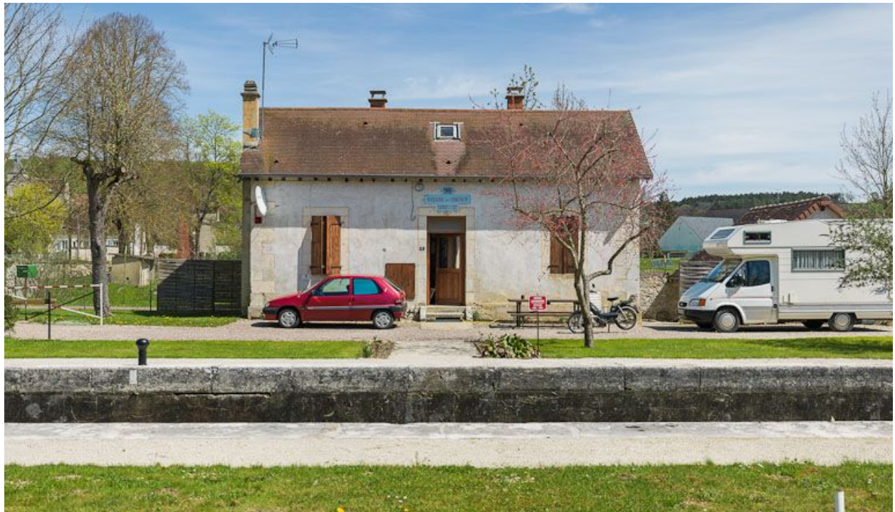
La maison éclusière de face.
