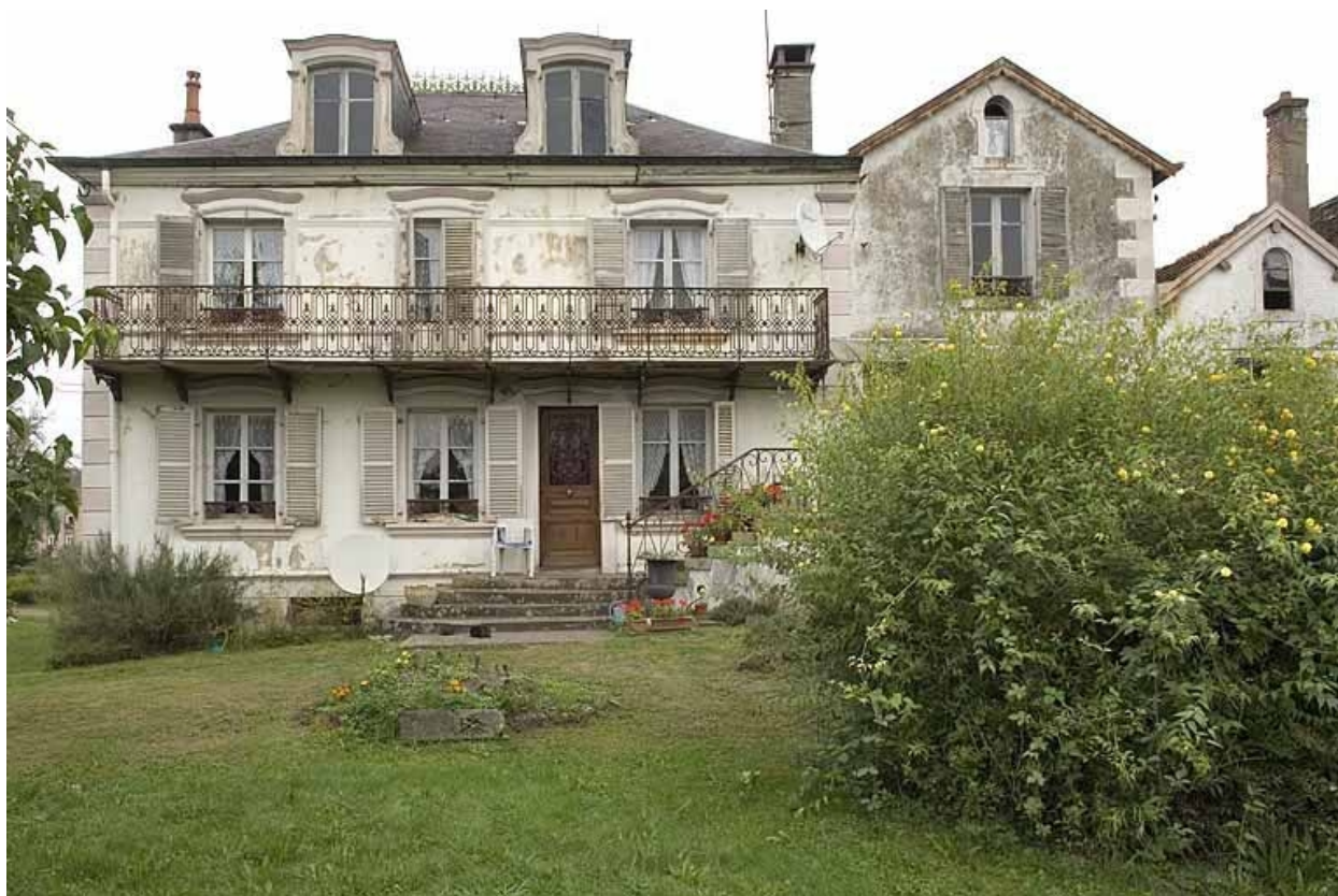
Logement patronal. Façade antérieure.
