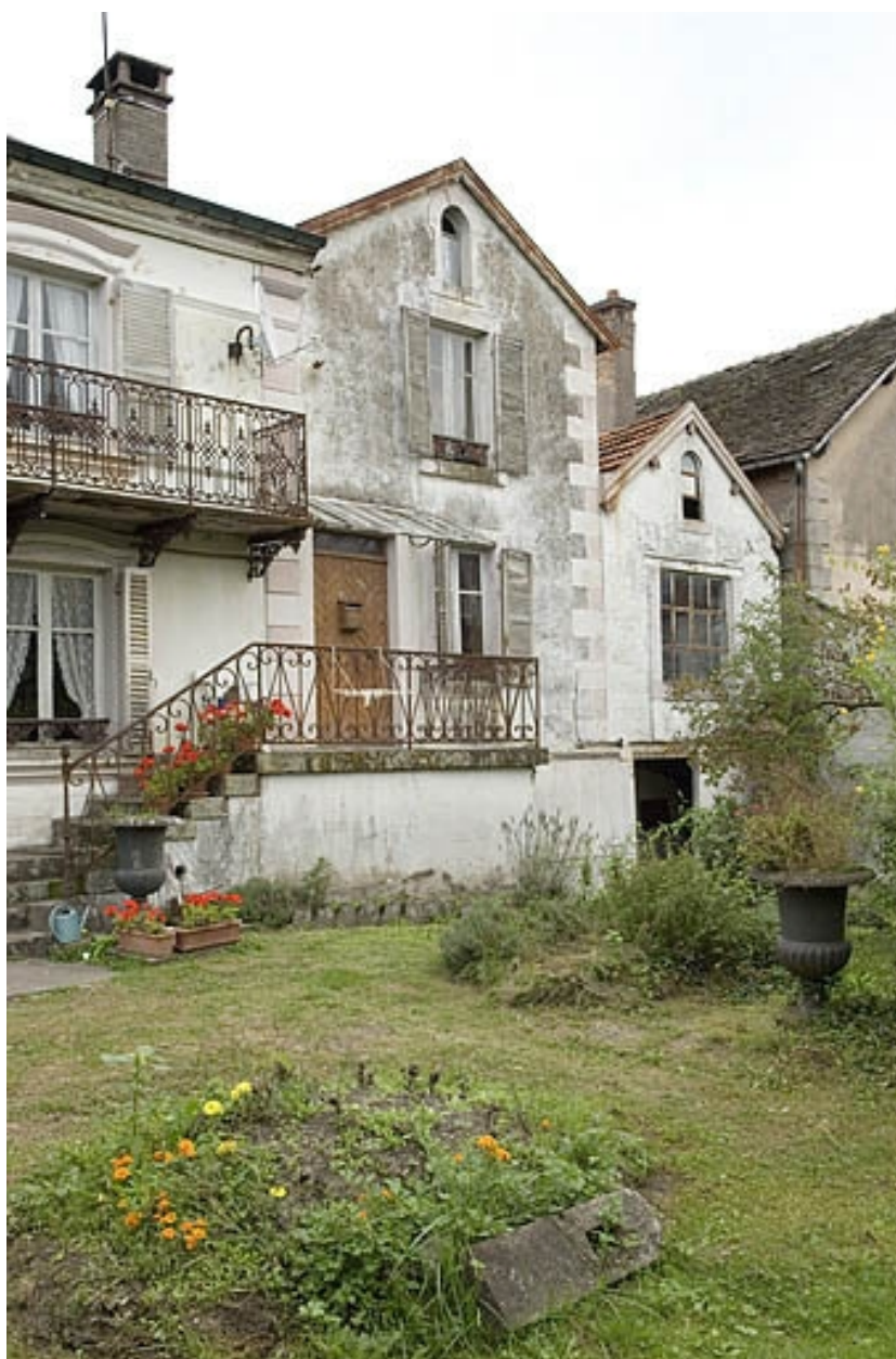
Pignons des bureaux et de l'entrepôt industriel.
