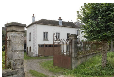
Vue depuis l'entrée. Phot. Jérôme Mongreville IVR43_20067000686NUCA
