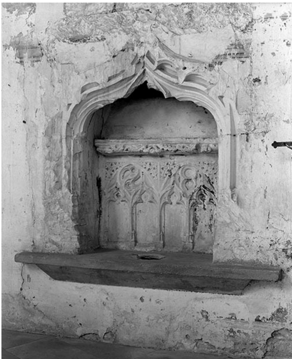
Piscine du mur droit du chœur.
