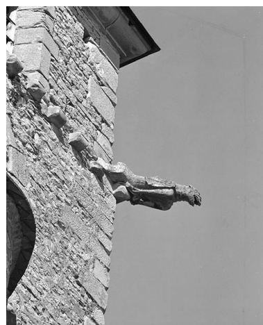
Façade droite du chœur, détail : gargouille droite. Phot. Michel Thierry IVR26_19748900790X
