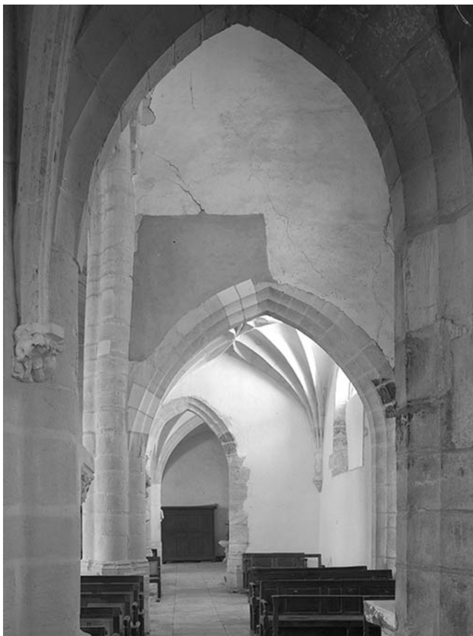
Collatéral gauche, vue depuis le mur postérieur.
