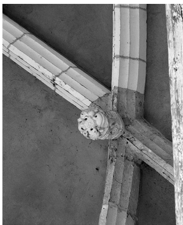
Choeur, détail : clef de voûte. Phot. Michel Thierry IVR26_19748900779X
