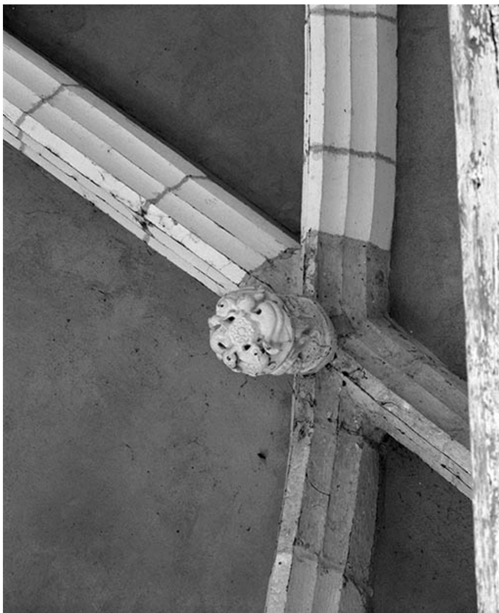
Choeur, détail : clef de voûte.
