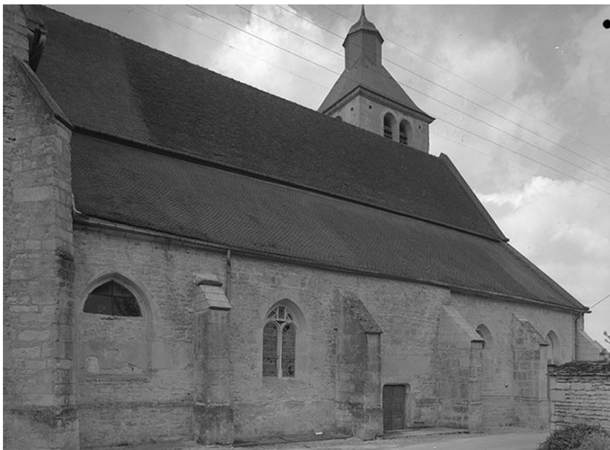
Façade du bas-côté nord.
