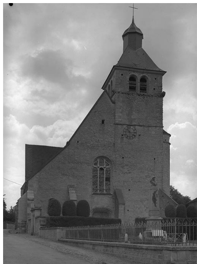
Façade occidentale avec clocher. Phot. Michel Thierry IVR26_19748900785V
