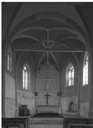
Choeur avec voûte d'ogives. Peinture monumentale. Phot. Michel Thierry IVR26_19748900767V
