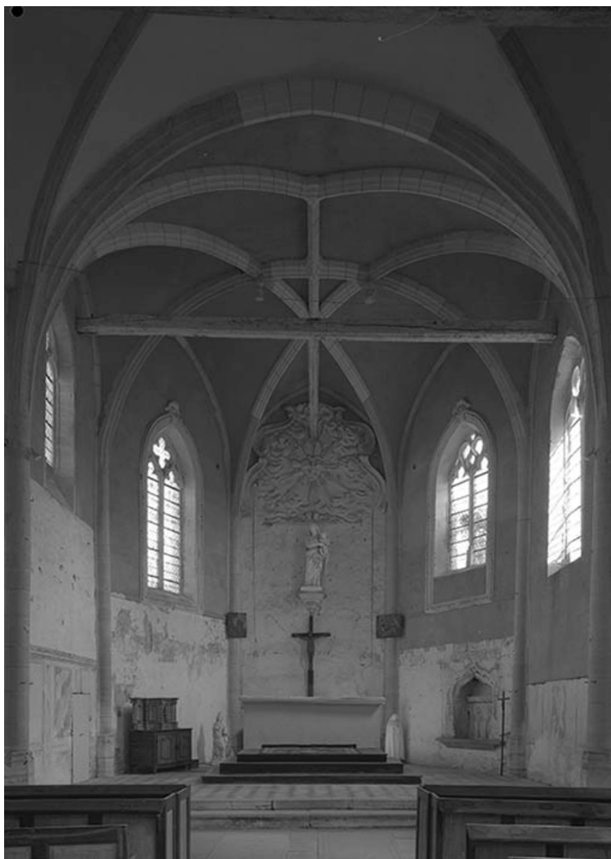
Choeur avec voûte d'ogives. Peinture monumentale.
