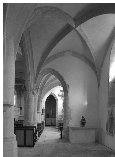
Collatéral droit, vue depuis le mur antérieur. Phot. Michel Thierry IVR26_19748900771V
