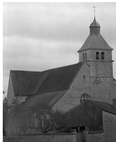
Façade occidentale avec nef, bas-côté et clocher. Phot. Michel Thierry IVR26_19748901419X
