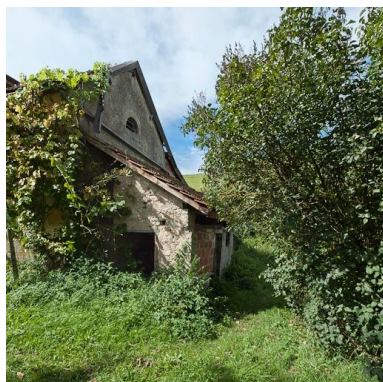
Vue de l'annexe latérale. Phot. Pierre-Marie Barbe-Richaud IVR26_20112104087NUC2AQ
