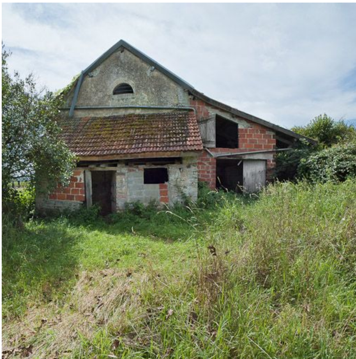
Vue latérale de la maison éclusière.
