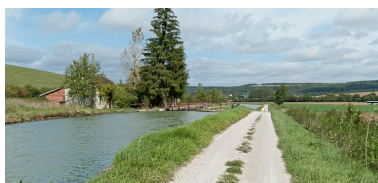
Vue du site d'écluse depuis l'amont. Phot. Pierre-Marie Barbe-Richaud IVR26_20112104084NUC4AQ
