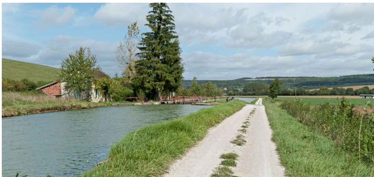
Vue du site d'écluse depuis l'amont.
