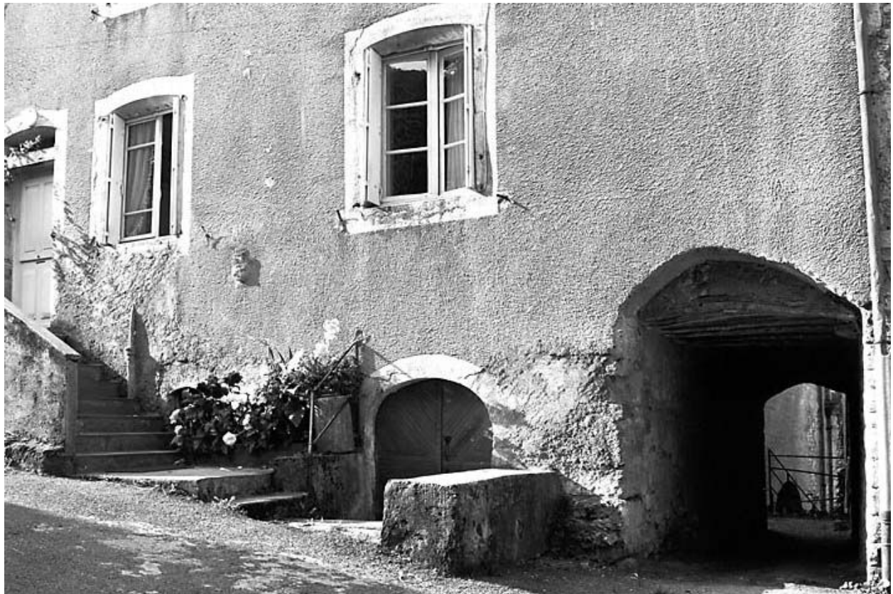
Vue du rez-de-chaussée.
