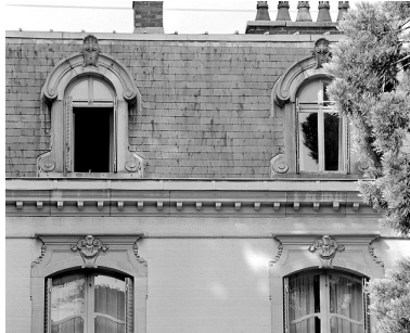
Façade antérieure, détail de l'étage de comble. Phot. Yves Sancey IVR43_19853900301X
