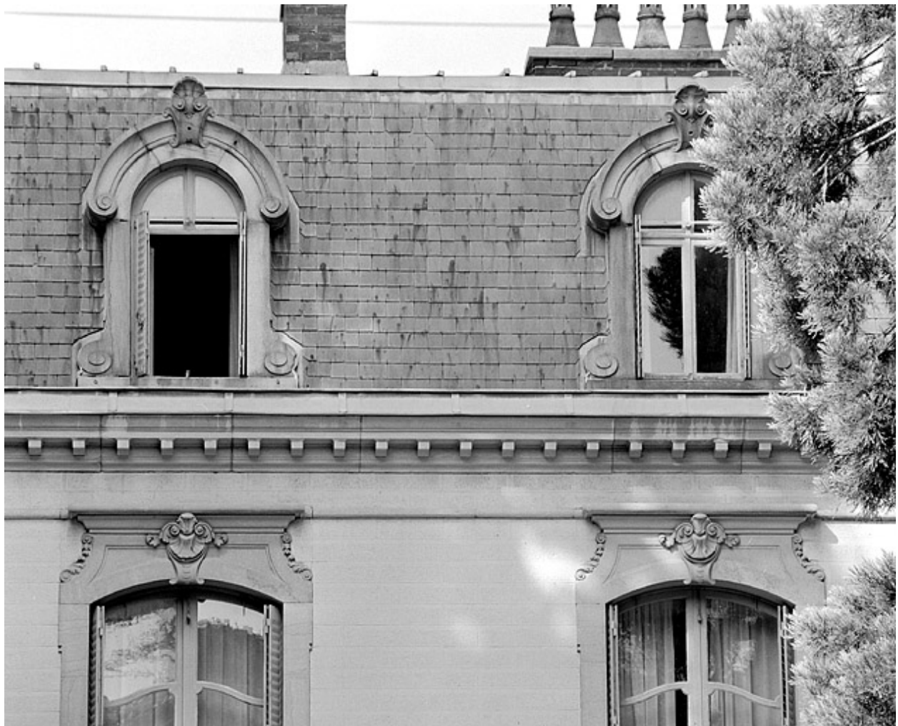
Façade antérieure, détail de l'étage de comble.
