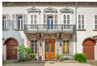
Façade est. Détail de la partie centrale. Phot. Jérôme Mongreville IVR43_20233900837NUC4A
