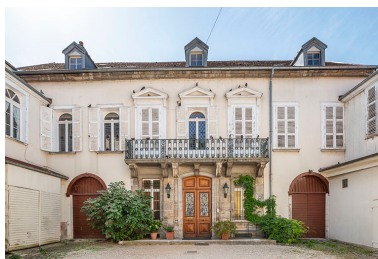
Façade sur cour. Vue de face. Phot. Jérôme Mongreville IVR43_20233900833NUC4A
