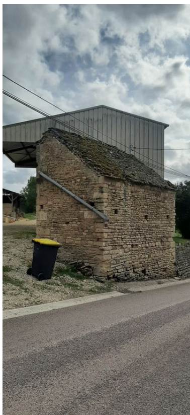
vue du bâtiment depuis le nord. Phot. Baptiste Quost IVR26_20242100074NUCA
