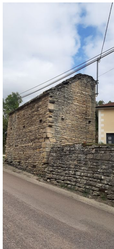
Vue de la construction depuis le sud. Phot. Baptiste Quost IVR26_20242100075NUCA
