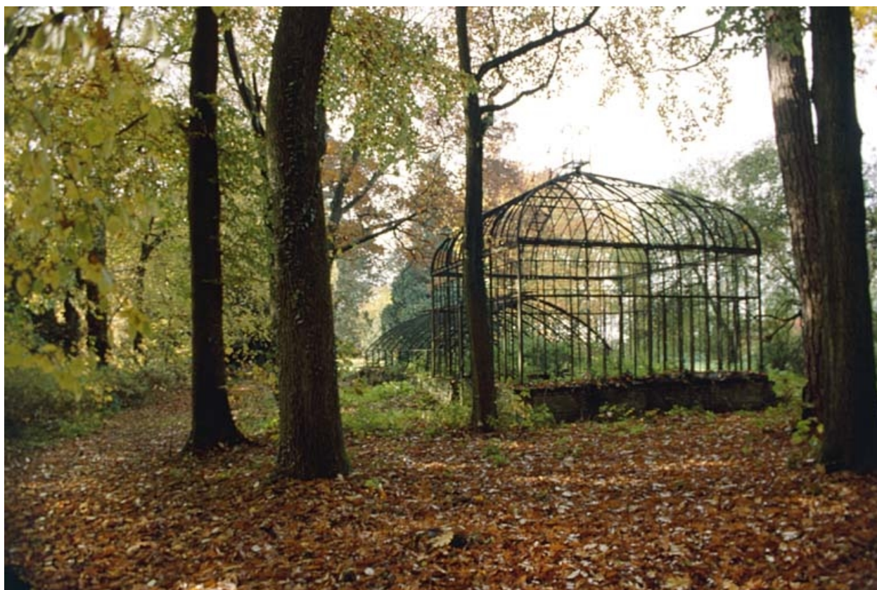
Vue d'ensemble de la serre.
