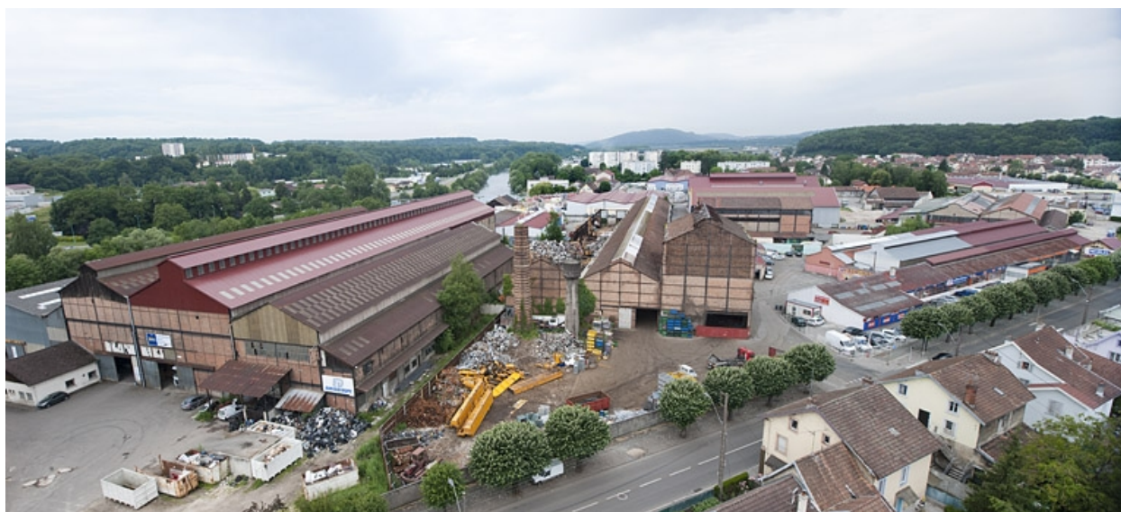
Les Forges d'Audincourt. Vue plongeante depuis l'est.
