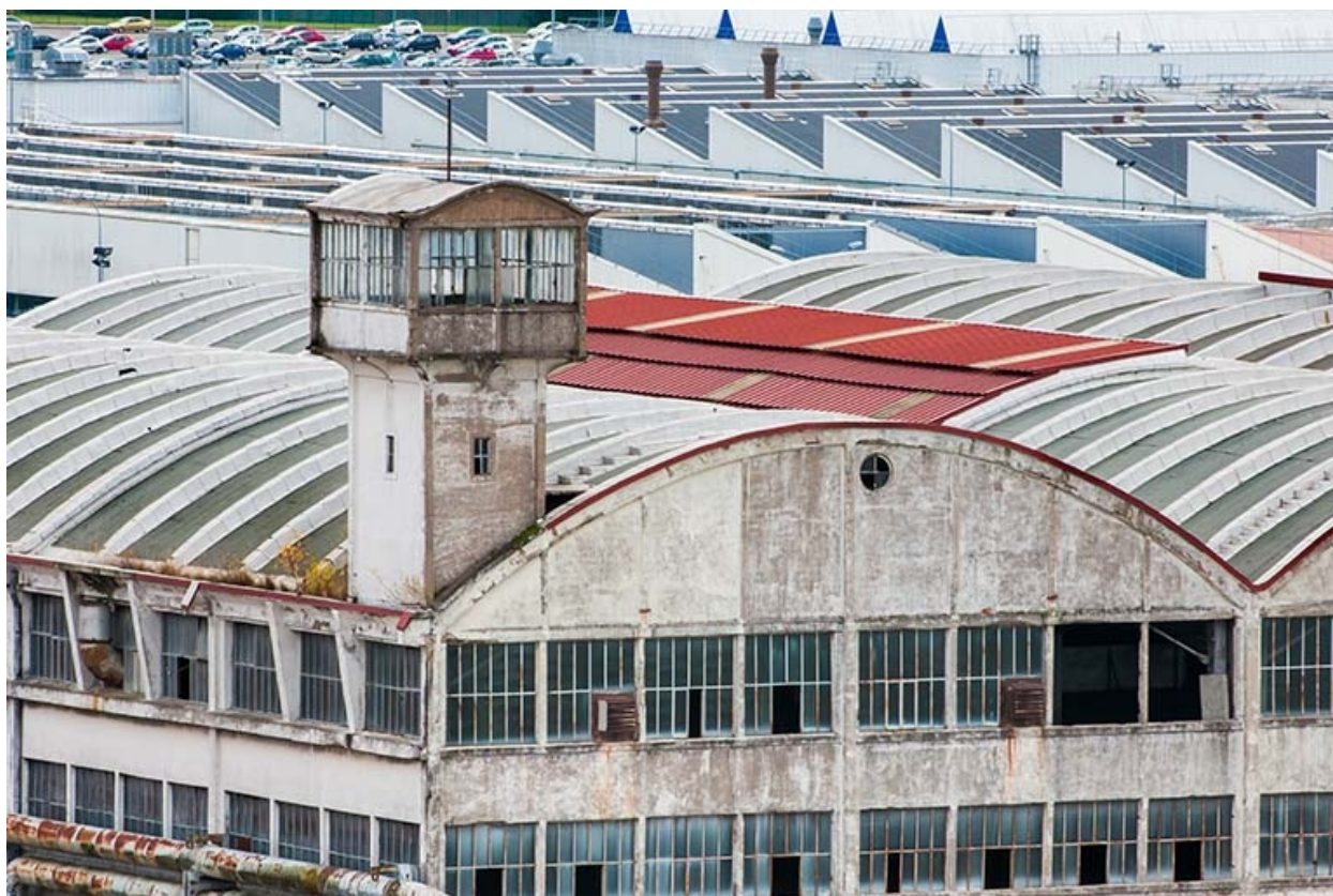
Toitures de l'usine Peugeot de Sochaux-Montbéliard.
