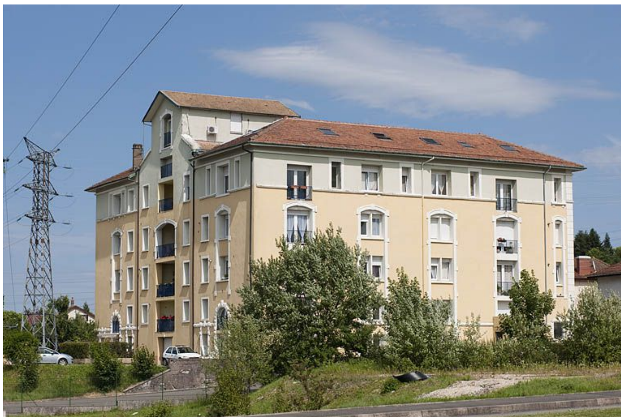
Sous-station électrique à Etupes.
