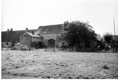
Vue générale. Phot. Yves Sancey IVR43_19753900487Z
