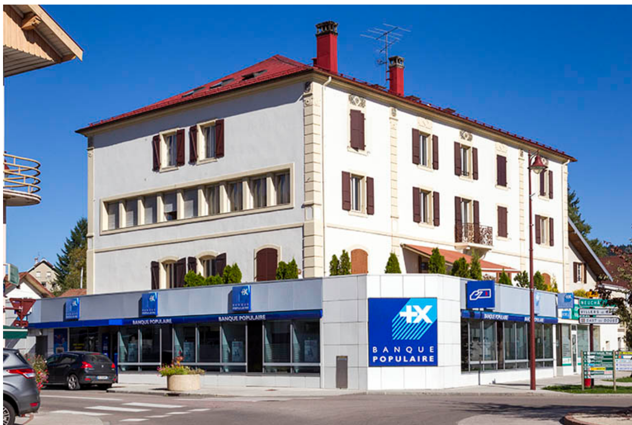
Façades antérieure et latérale gauche.
