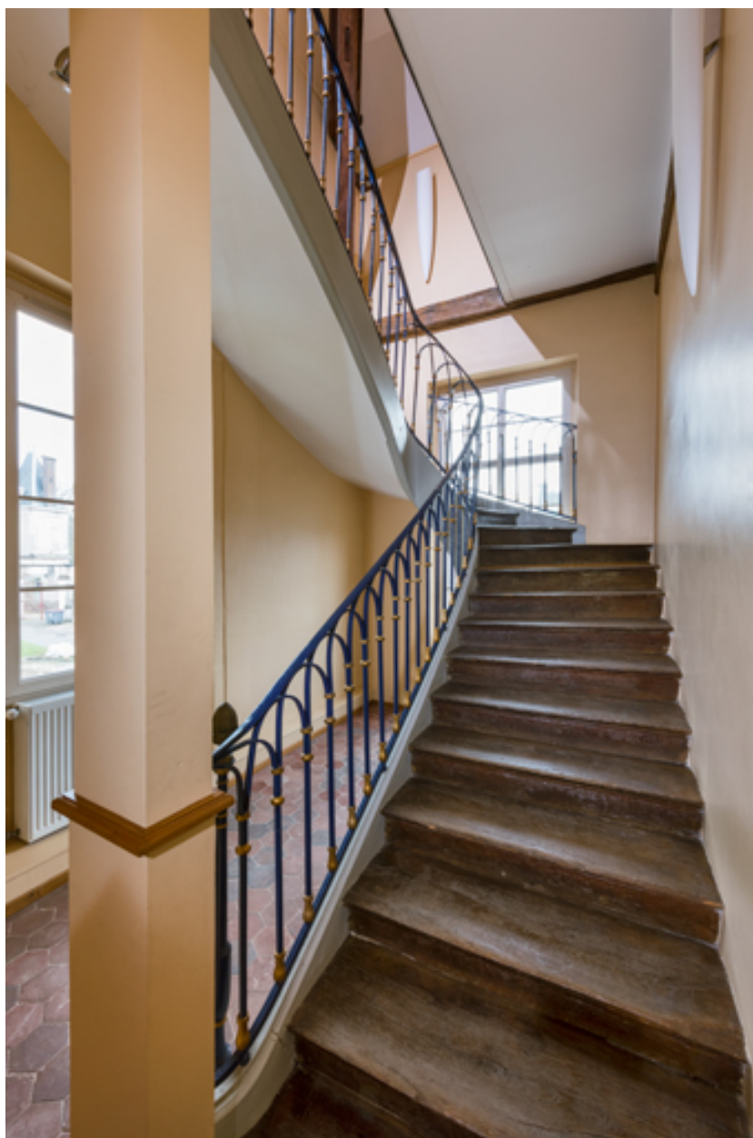
Escalier donnant accès à l'étage en surcroît.
