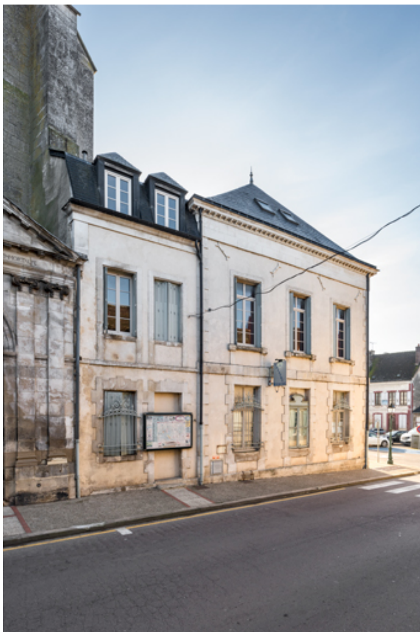
Façade latérale gauche, de trois quarts droite.
