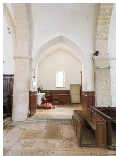
Chapelle sud-ouest. Phot. Pierre-Marie Barbe-Richaud IVR26_20162100222NUC2A
