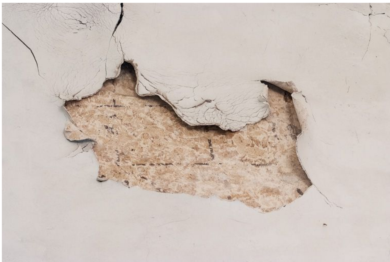
Détail de l'enduit du choeur.
