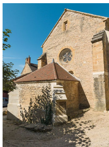
Chevet et sacristie. Phot. Pierre-Marie Barbe-Richaud IVR26_20162100441NUC2A
