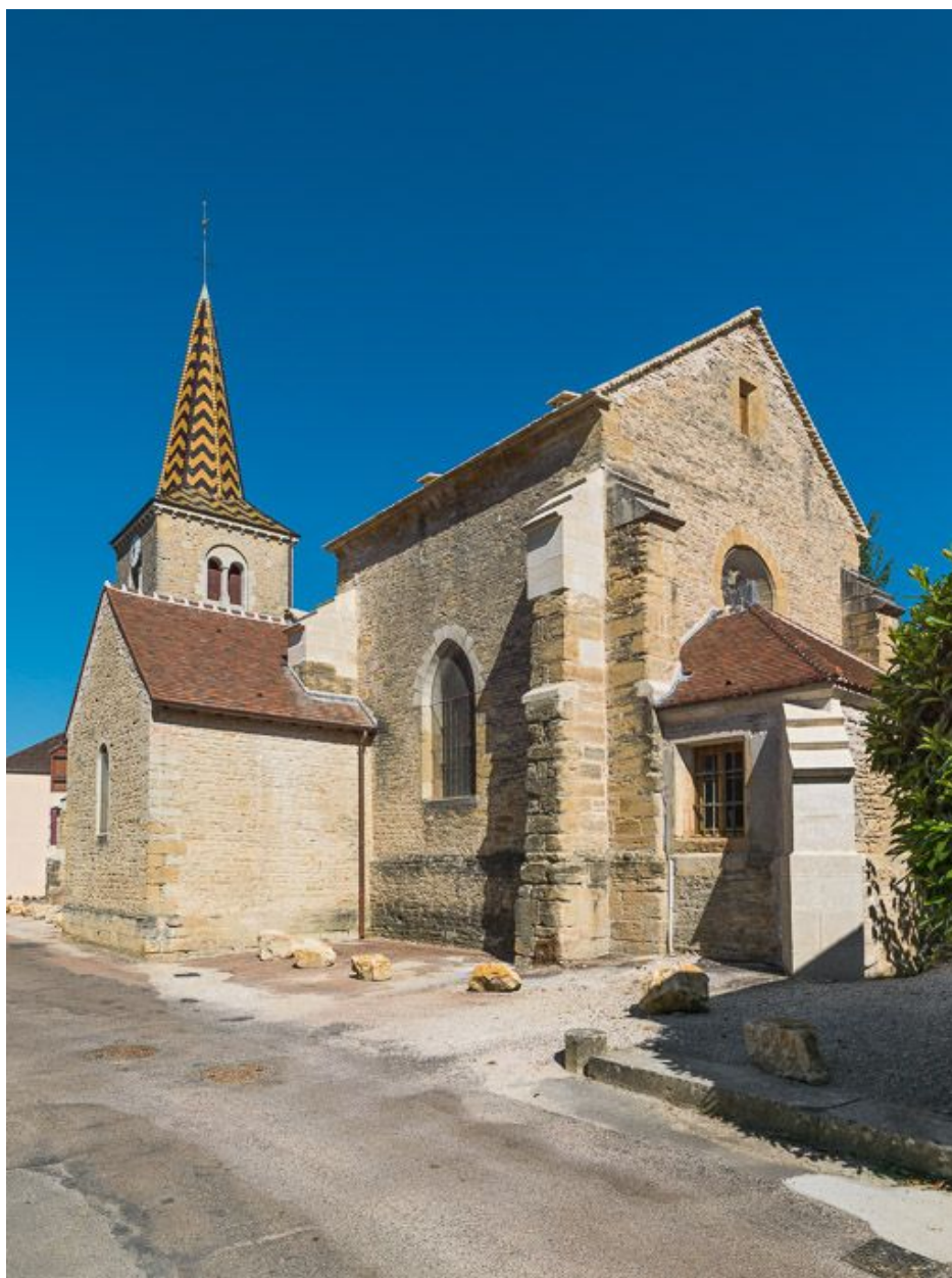
Elévation de trois quarts, côté chevet.
