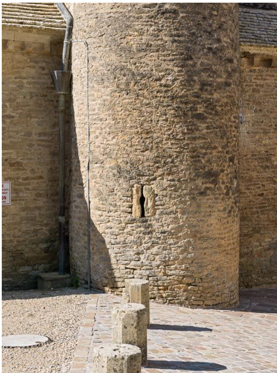
Tourelle d'escalier : détail du jour en archère.
