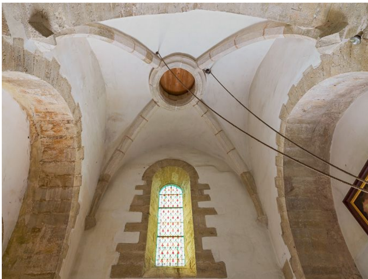
Voûte de la travée sous clocher.
