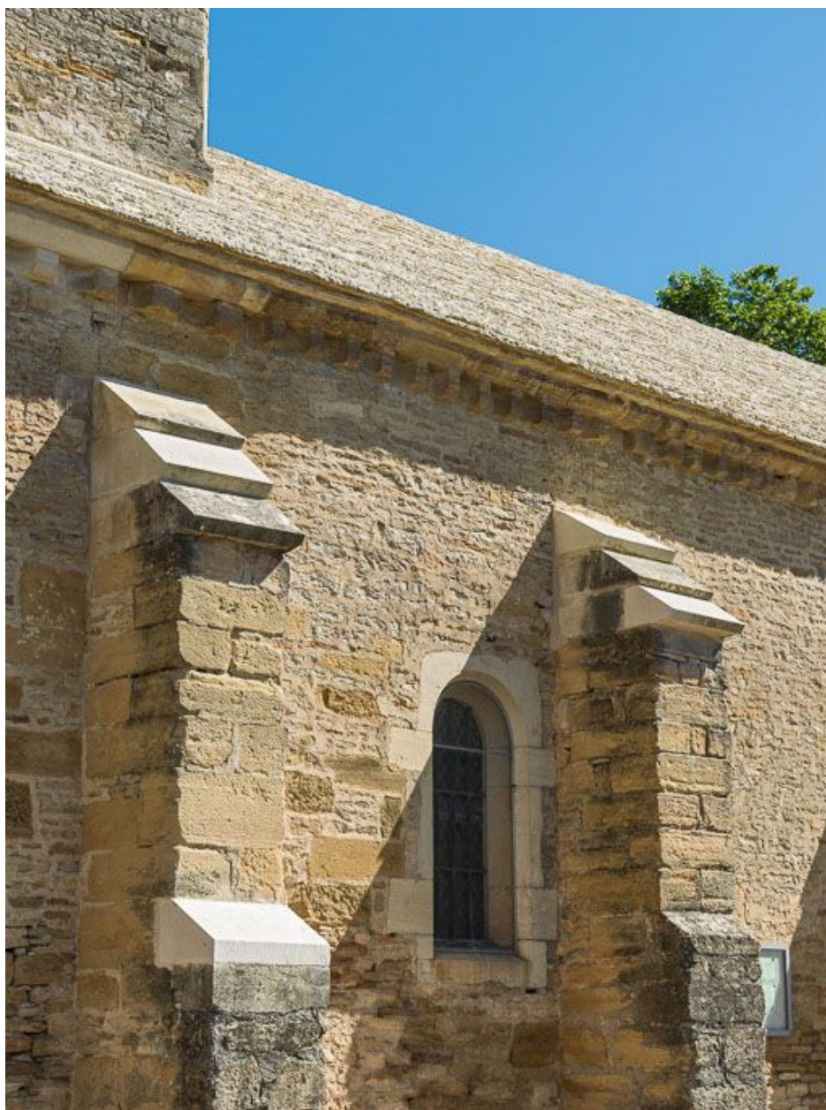
Elévation sud-ouest, détail de la travée.
