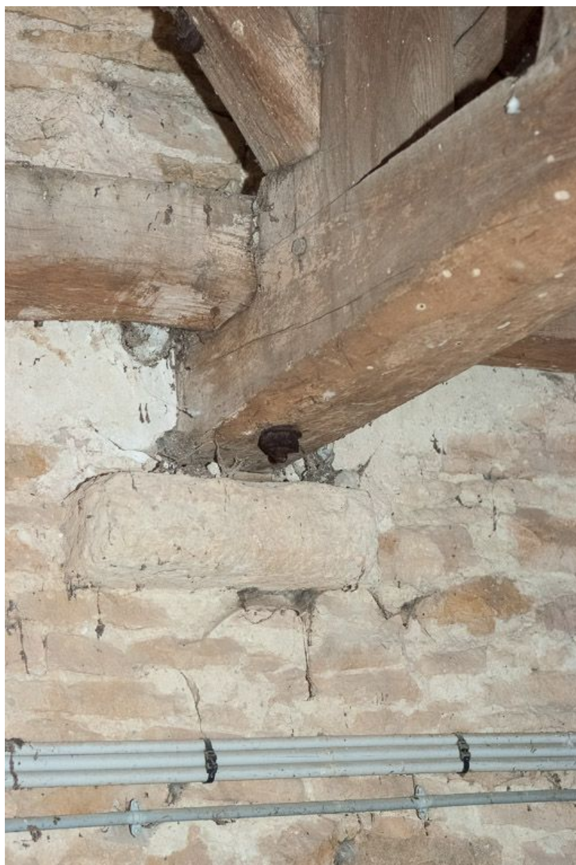
Détail d'un support en pierre du beffroi.
