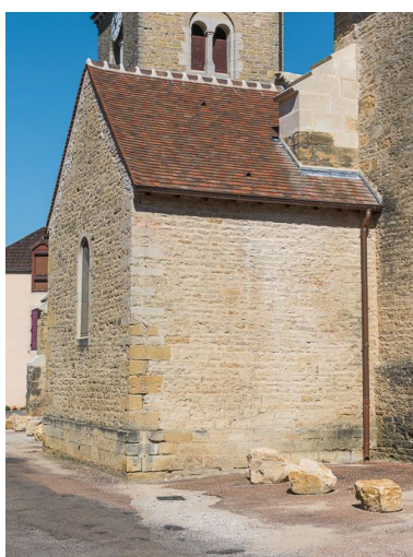
Chapelle sud-ouest. Phot. Pierre-Marie Barbe-Richaud IVR26_20162100440NUC2A
