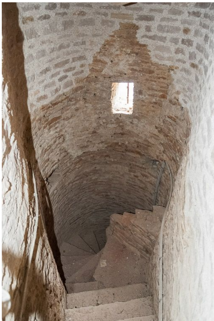
Partie supérieure de la tourelle d'escalier.
