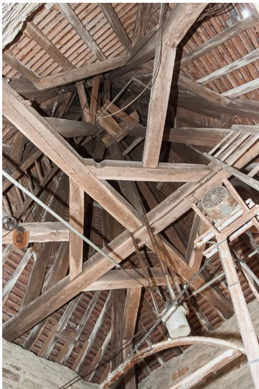
Charpente de la flèche du clocher.
