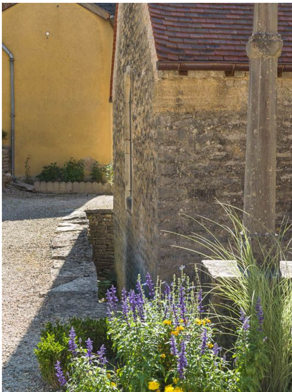
Fossé d'assainissement de la chapelle nord-est.
