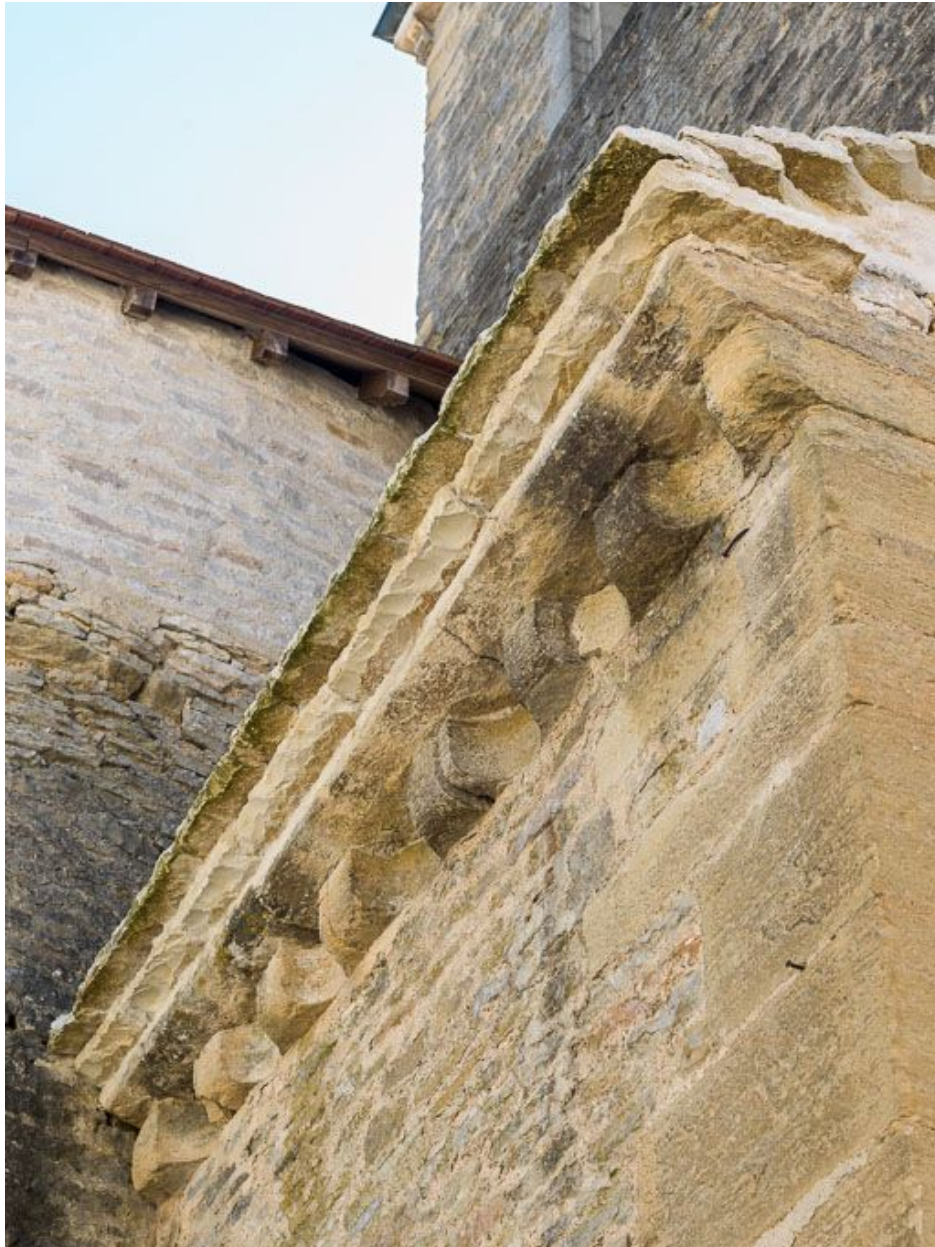
Elévation nord-est, détail des corniches.
