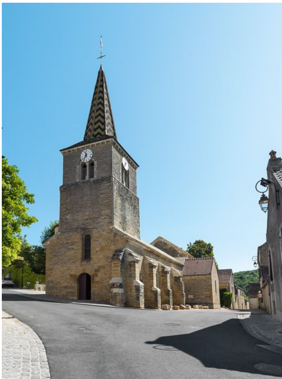
Vue d'ensemble, façade et élévation sud-ouest.
