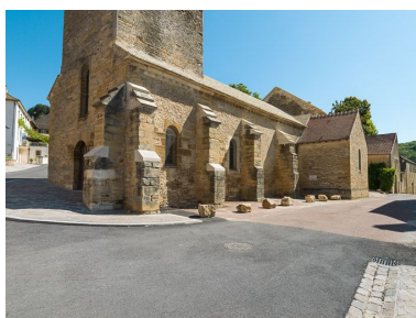
Élévation sud-ouest. Phot. Pierre-Marie Barbe-Richaud IVR26_20162100434NUC2A
