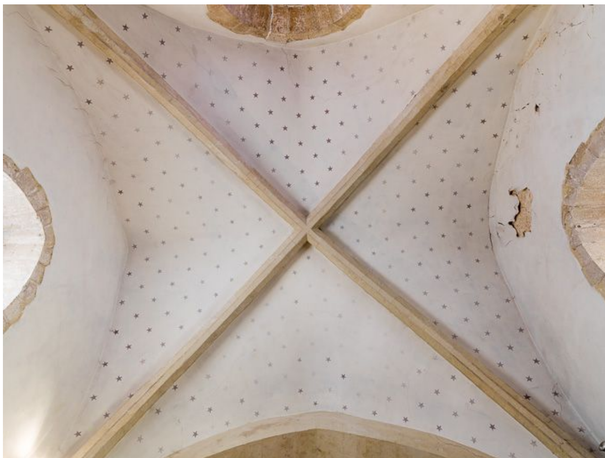
Voûte du chœur.
