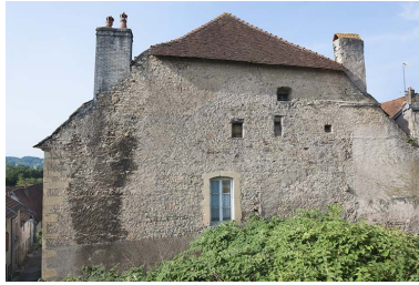
Façade latérale droite. Phot. Jérôme Mongreville IVR43_20127000653NUC4A
