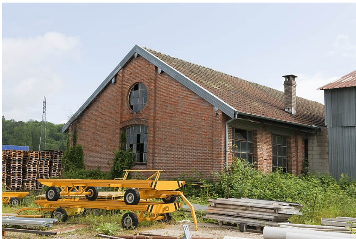
Entrepôt industriel vu de trois quarts arrière.
