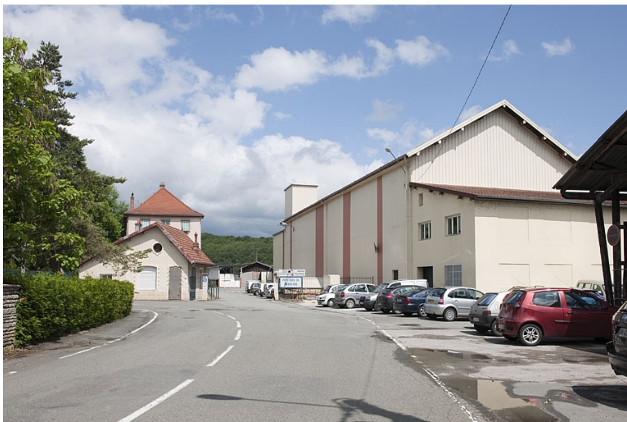
Vue d'ensemble de l'entrée de la papeterie.
