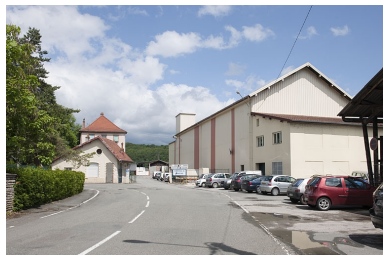
Vue d'ensemble de l'entrée de la papeterie. Phot. Jérôme Mongreville IVR43_20122500993NUC4A
