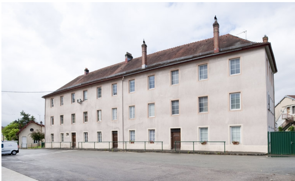
Bâtiment administratif et logement patronal. Façade antérieure.
