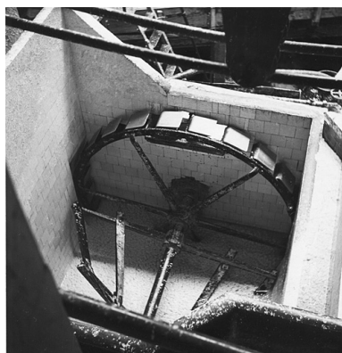
Cuve de pâte à papier. Photogr., s.n., s.d. [vers 1950 ?] Phot. Raphaël Favereaux, Autr. IVR43_20122501367NUC2A
