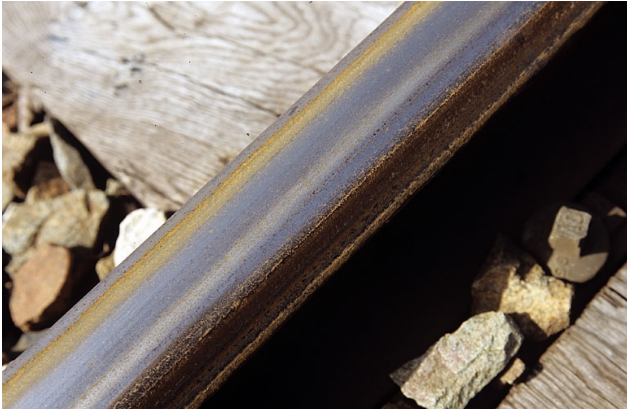
Usure d'un rail, sur le viaduc de Morbier.
