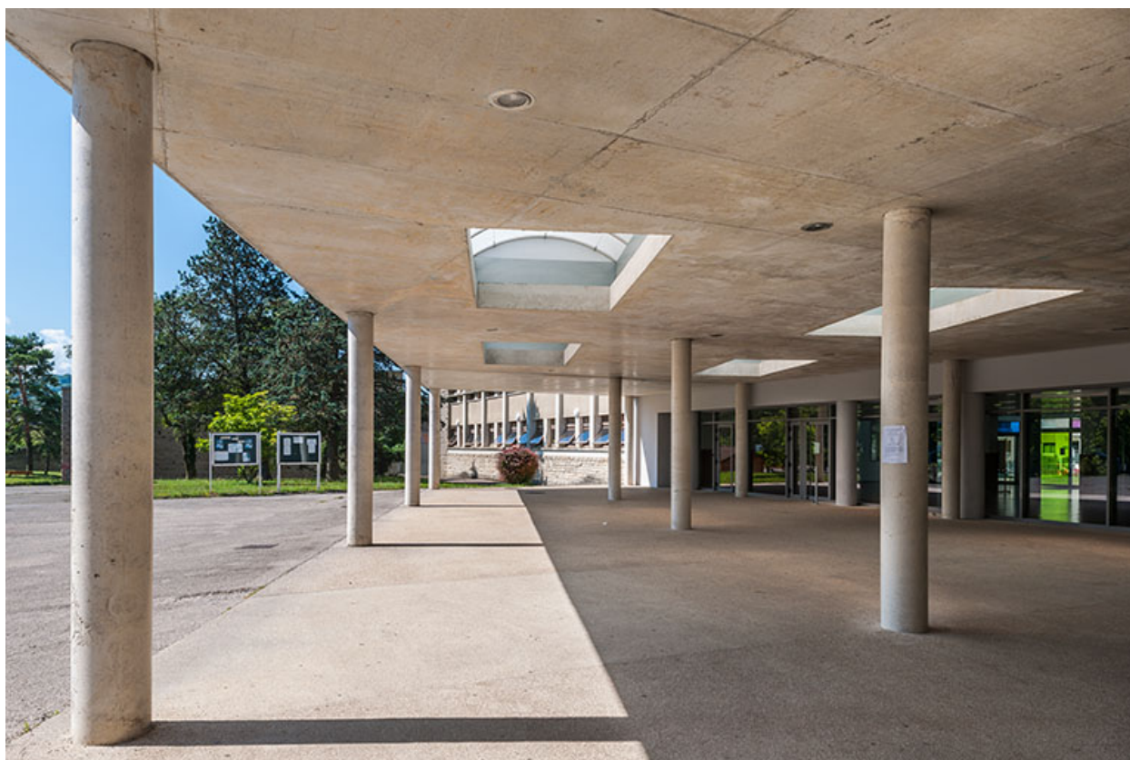
Liaison couverte entre bâtiments et préau.
