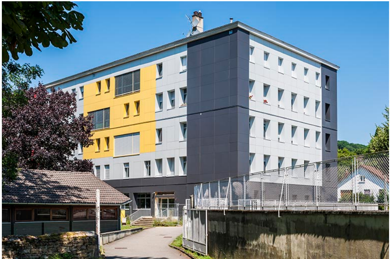
Façade latérale de l'internat après rénovation.
