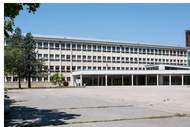
Vue de la façade postérieure de l'internat. Phot. Jérôme Mongreville IVR43_20143900570NUC4A
