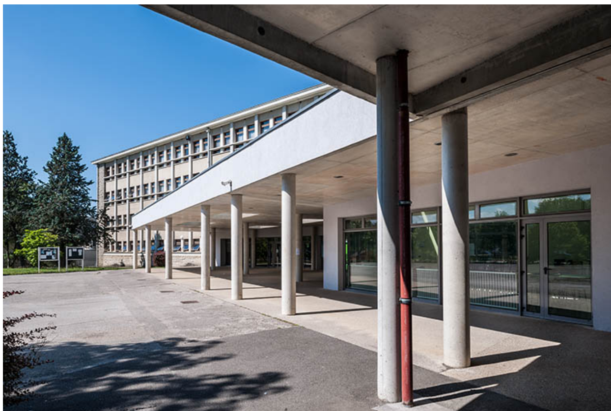
Liaison entre bâtiments : détail.
