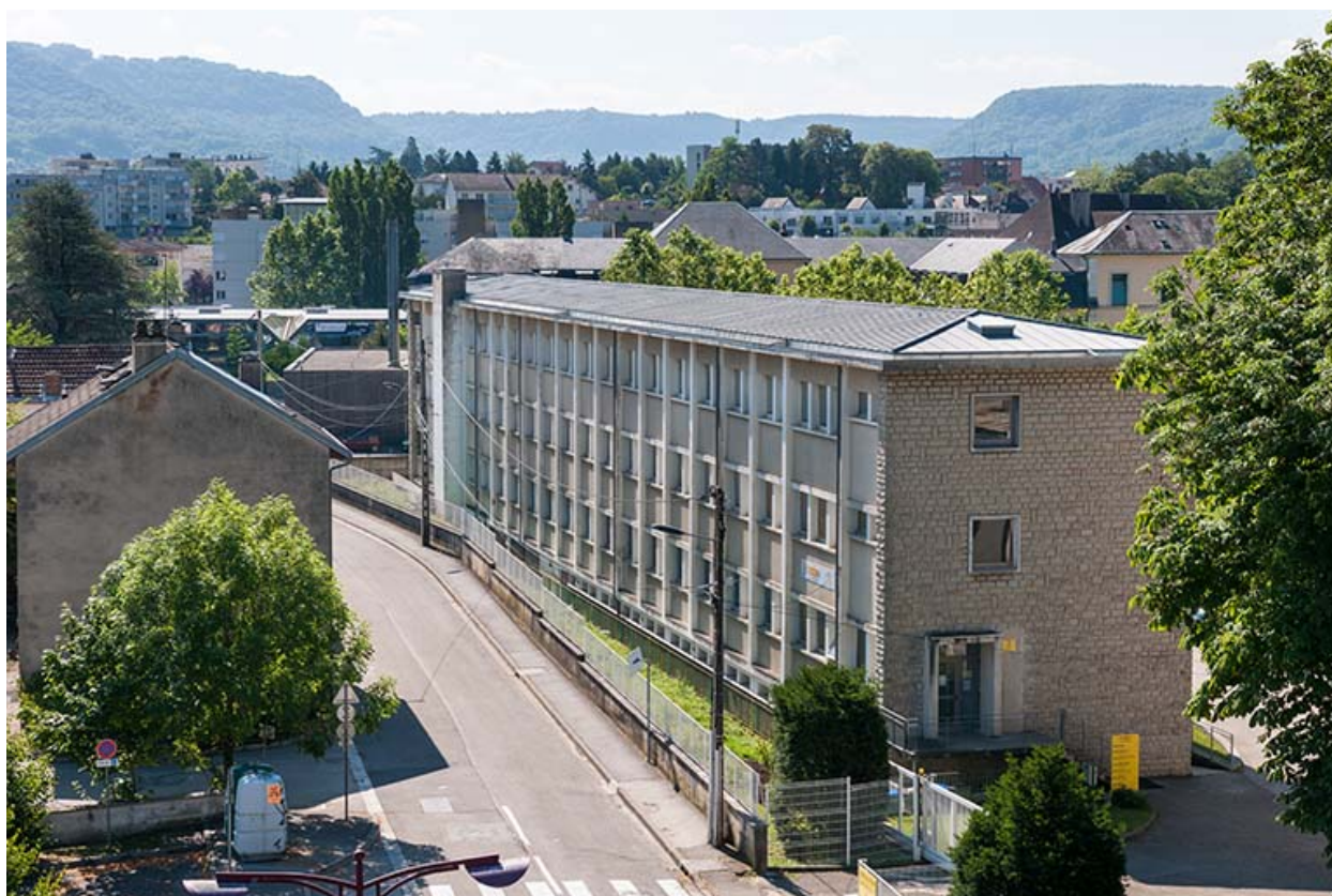
Vue trois quart de l'externat, ancien GRETA.
