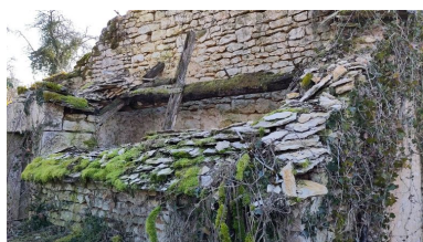
Détail des rangs de laves conservée sur le toit en appentis de l'extension nord. Phot. Baptiste Quost IVR26_20242100094NUCA
