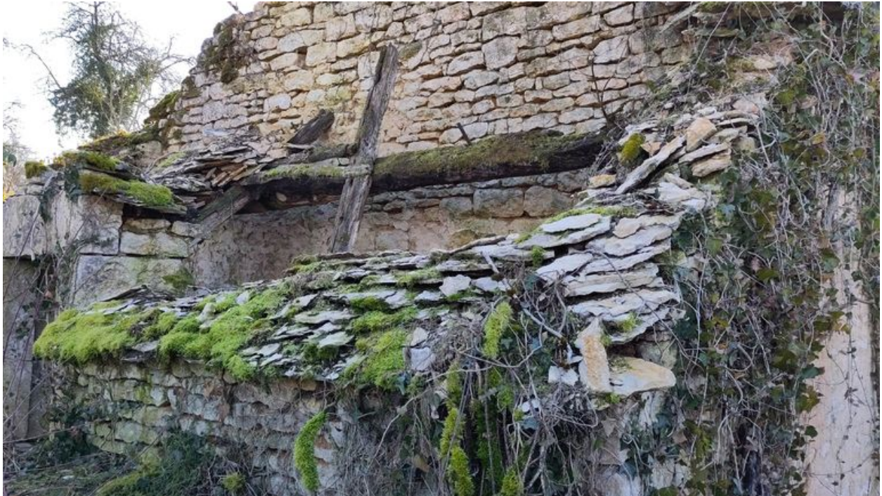
Détail des rangs de laves conservée sur le toit en appentis de l'extension nord.
