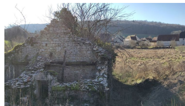
Vue du mur pignon nord du moulin et de l'extension adossée contre. Phot. Baptiste Quost IVR26_20242100093NUCA
