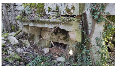
Détail d'une cheminée conservée à l'intérieur du moulin. Phot. Baptiste Quost IVR26_20242100095NUCA
