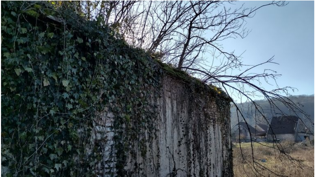
Détail de l'arase du mur gouttereau, conservant quelques laves témoins de l'ancienne couverture.
