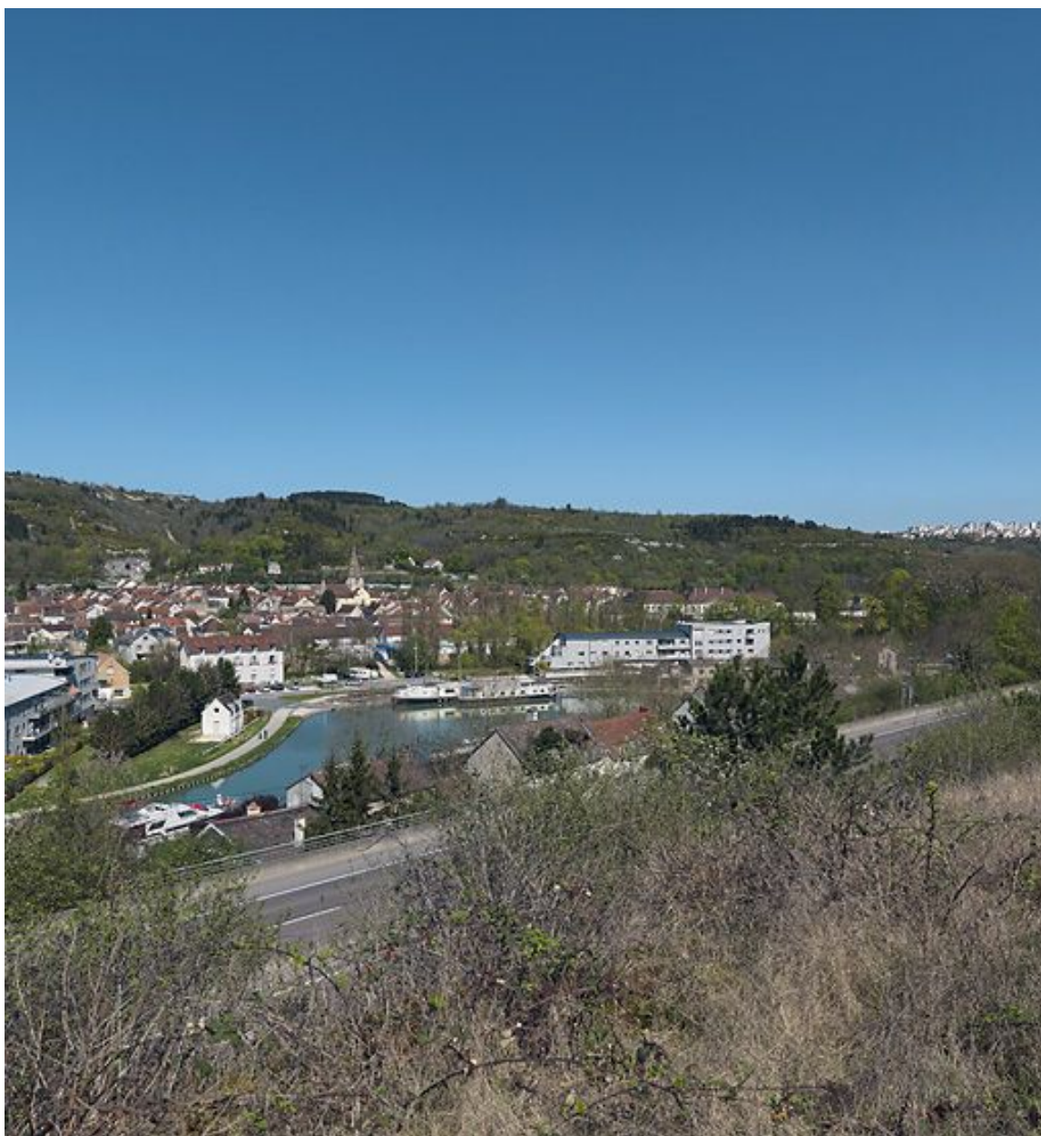
Vue d'ensemble du port de Plombières-lès-Dijon.
