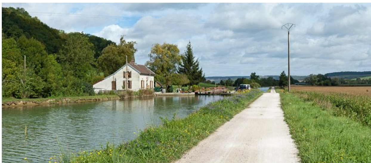
Vue du site d'écluse depuis l'amont.
