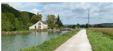
Vue du site d'écluse depuis l'amont. Phot. Pierre-Marie Barbe-Richaud IVR26_20112104062NUC4AQ
