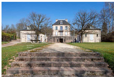
Vue d'ensemble. IVR43_20227000140NUC4A
