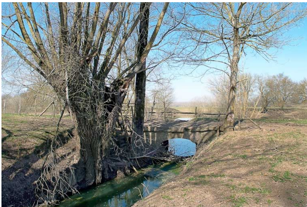
Ponceau : vue d'ensemble.
