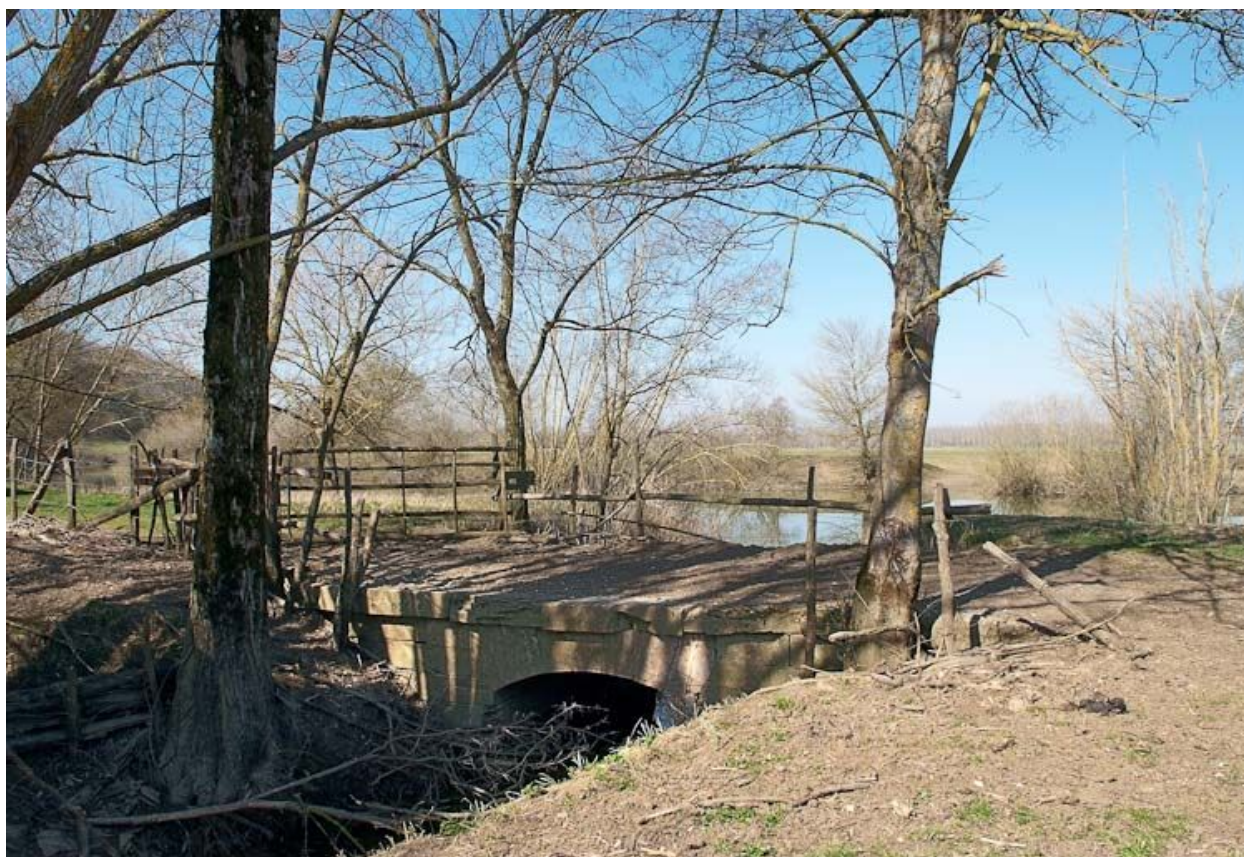
Ponceau : vue rapprochée.
