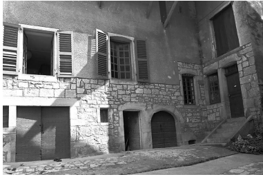
Elévation côté cour. Phot. Yves Sancey IVR43_19802500982X
