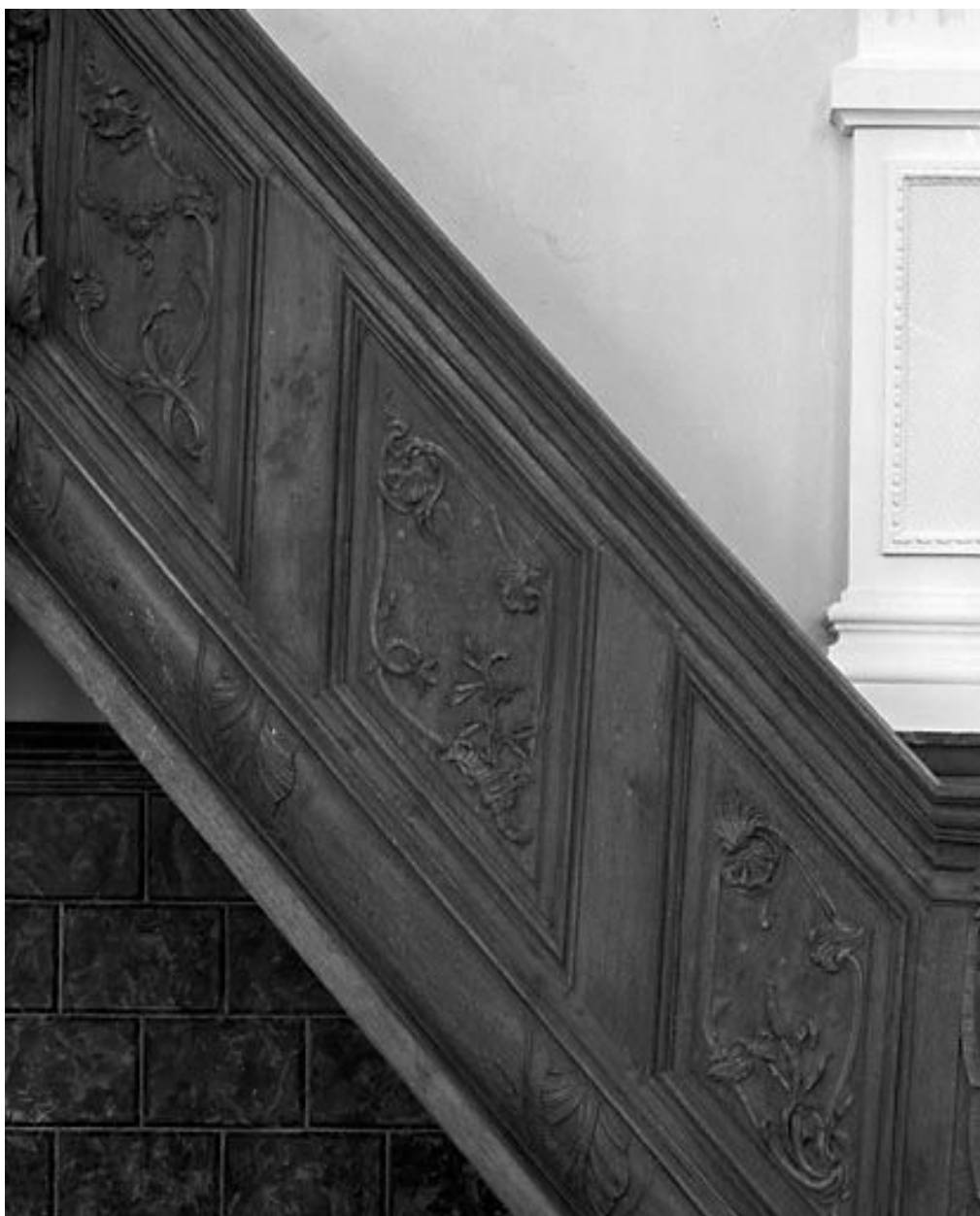
Détail de la rampe.
