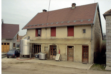
Façade antérieure. Phot. Jérôme Mongreville IVR43_19963900156ZA
