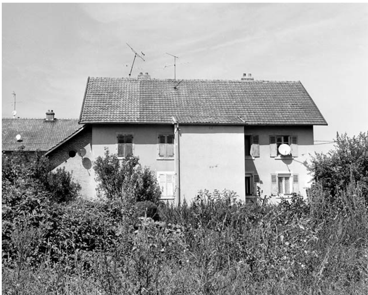
Façade postérieure d'un logement ouvrier collectif.
