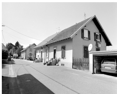
Maison à double logement. Phot. Yves Sancey IVR43_20019000482X
