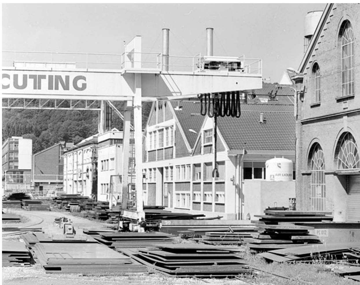
Alignement des pignons d'ateliers sur la rue 3.
