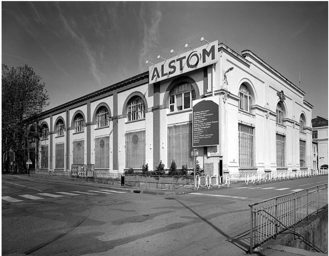
Bâtiment d'entrée à la porte des 3 Chênes.
