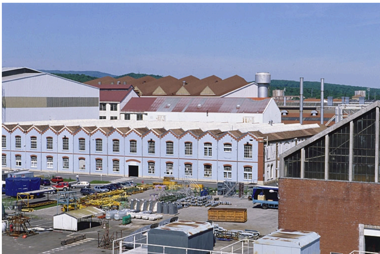
Vue plongeante depuis le sud-ouest.
