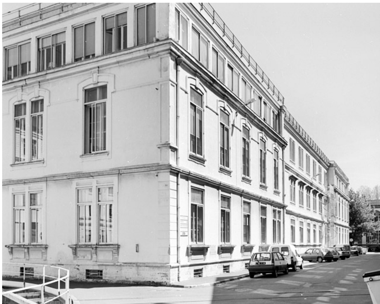
Vue de trois quarts des bureaux.
