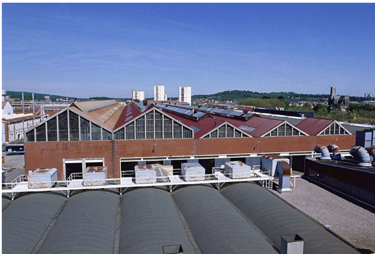
Les ateliers Traction depuis l'ouest.
