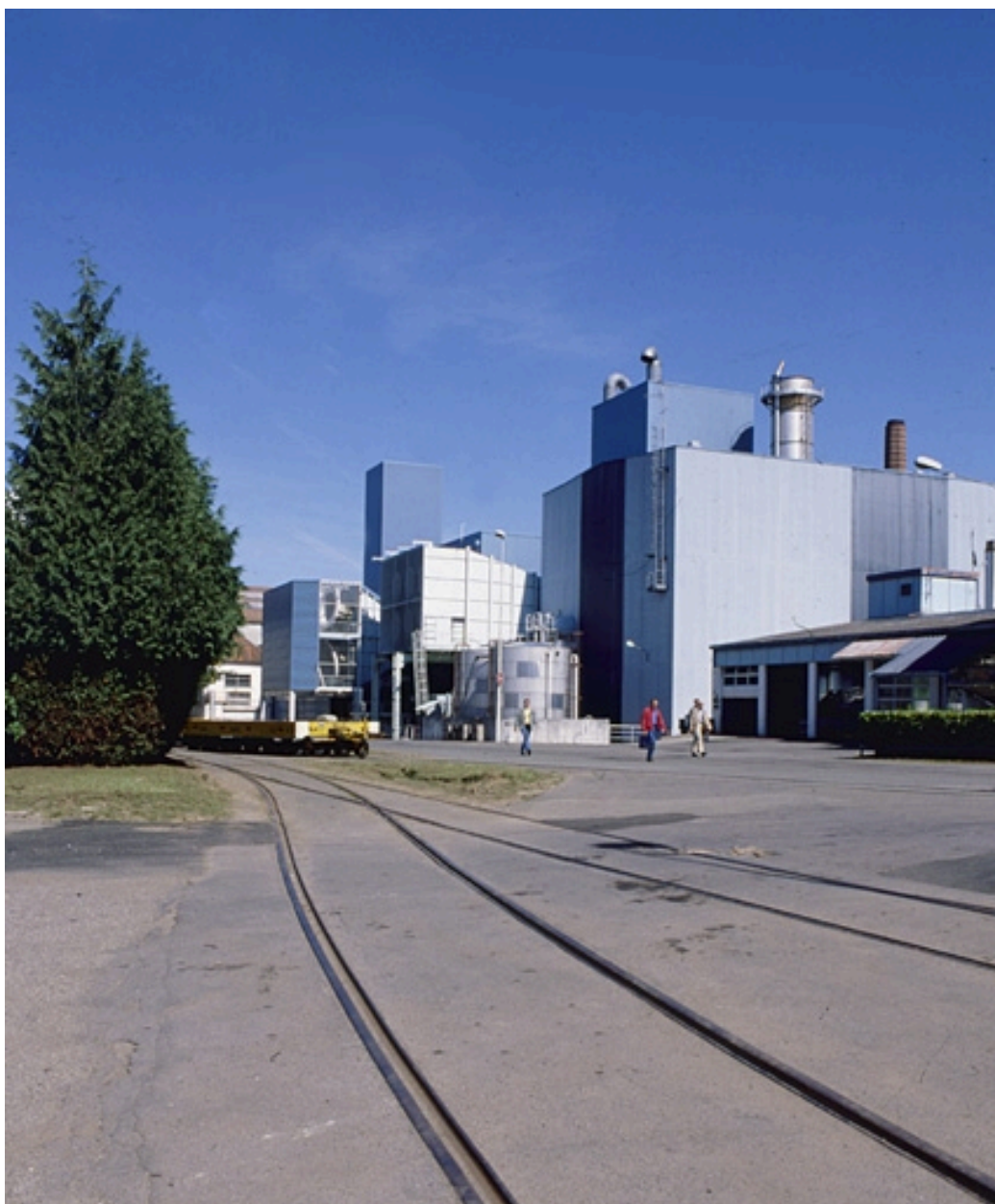
Ateliers de fabrication 53A et 57.
