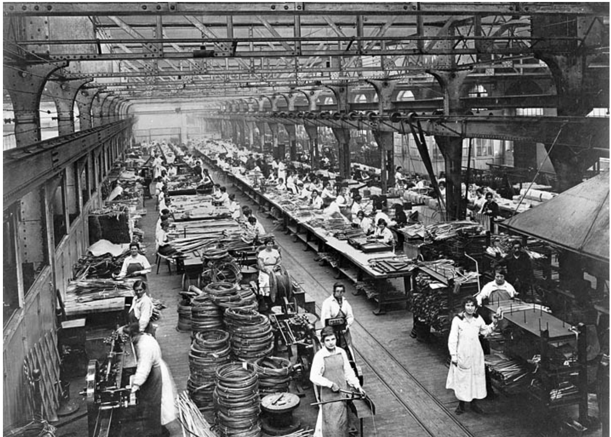
Bobinage dans l'atelier des grandes dynamos.
