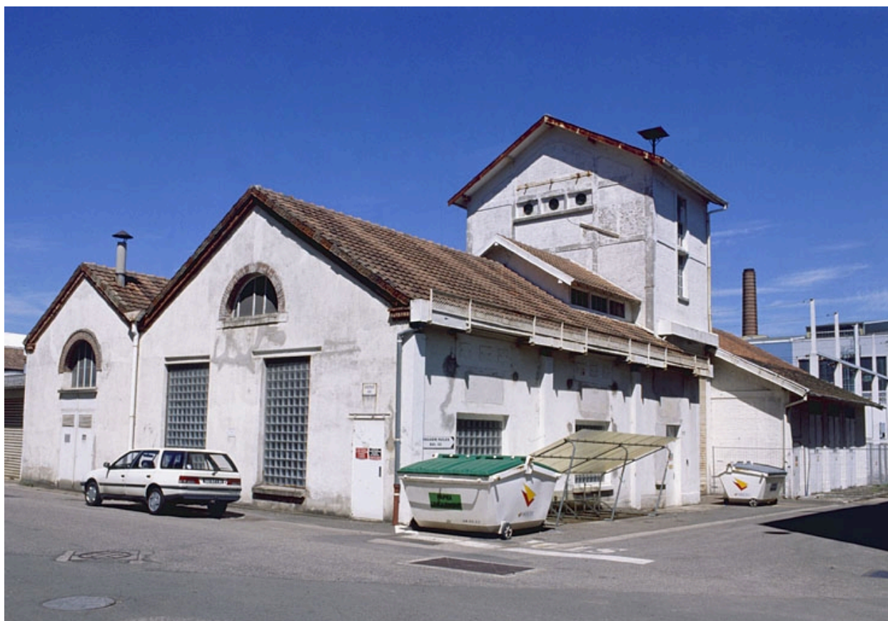
Station électrique et transformateur.
