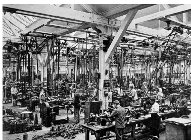
Atelier d'appareillage - Côté machines-outils. Phot. Jérôme Mongreville, Autr. Ernest (photographe) Mésière IVR43_20019000200X
