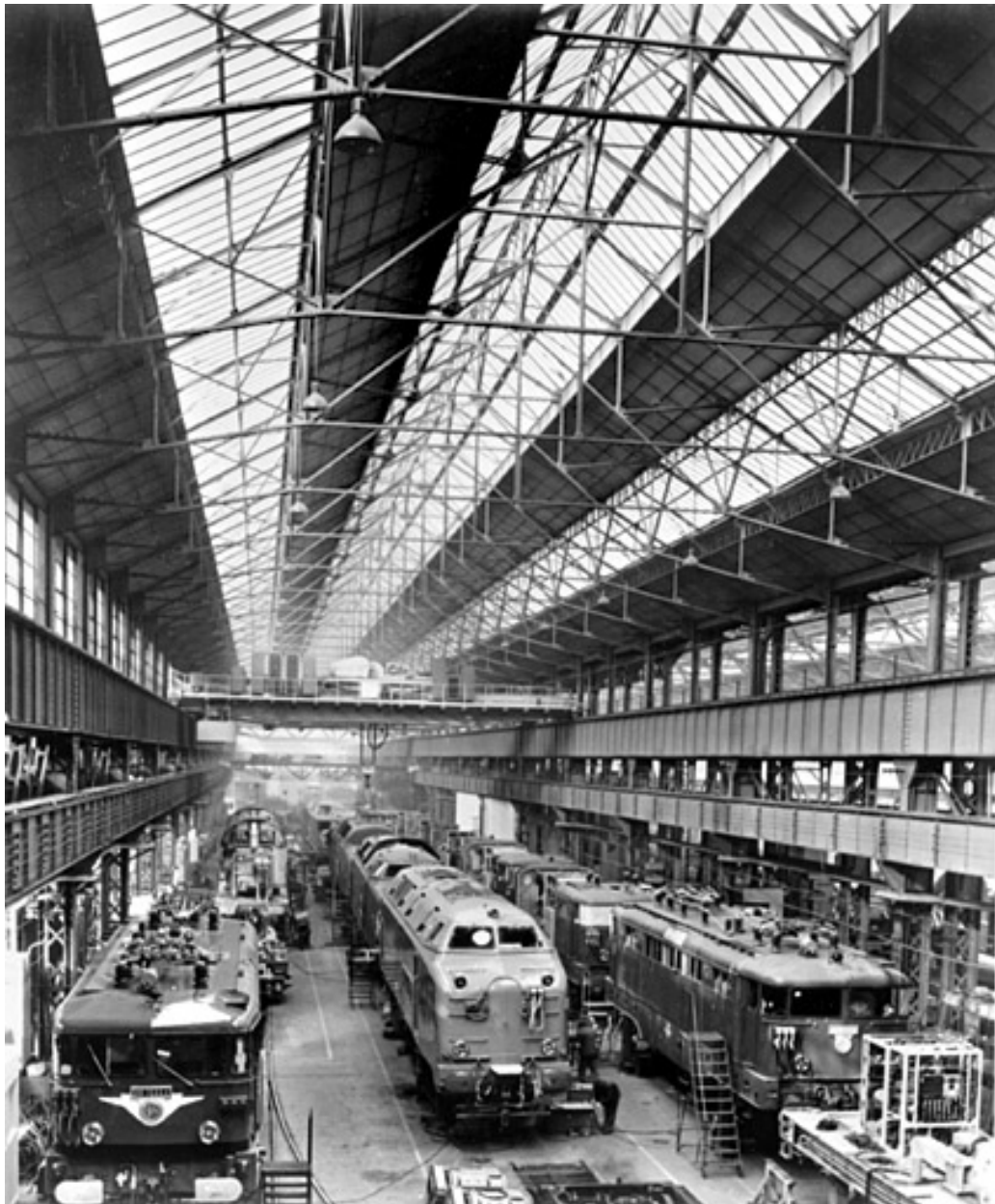
Hall de montage des locomotives électriques.
