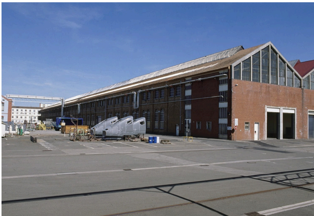
Façade nord de l'atelier Traction.
