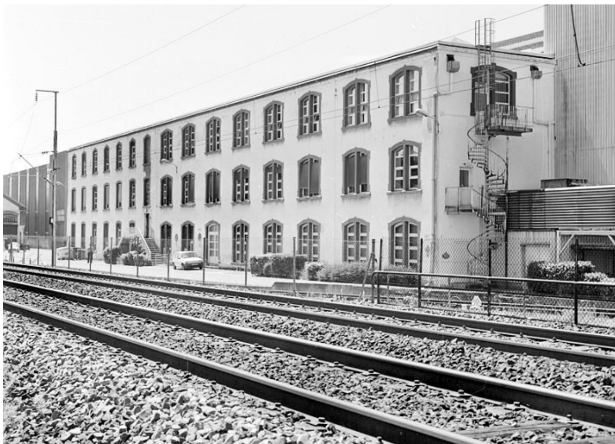
Façade est de l'ancien centre d'apprentissage.
