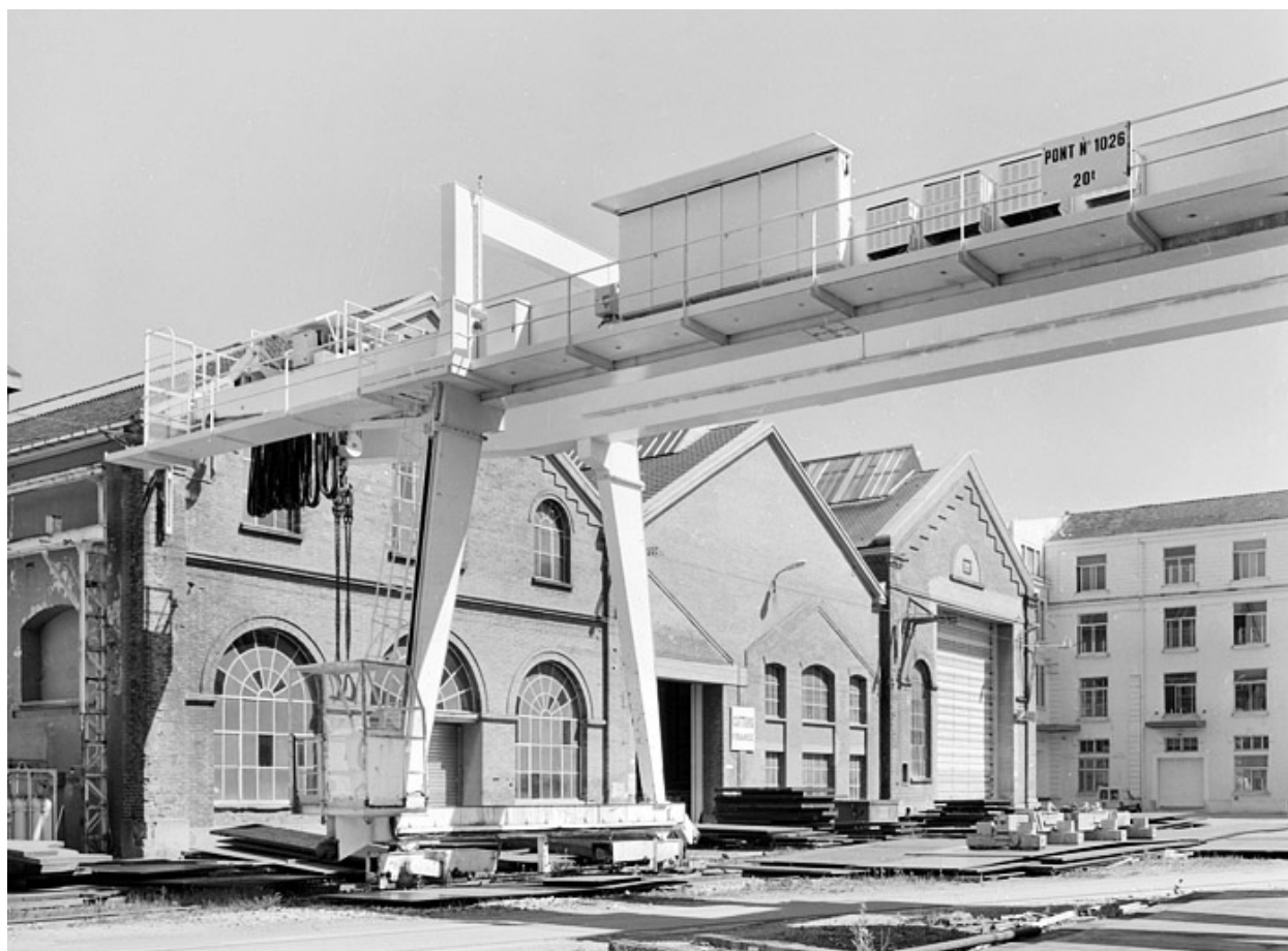
Rue 3 : pont roulant et ateliers de métallurgie.
