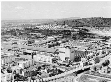
Vue aérienne depuis le nord-est. Phot. Jérôme Mongreville IVR43_20029000186X
