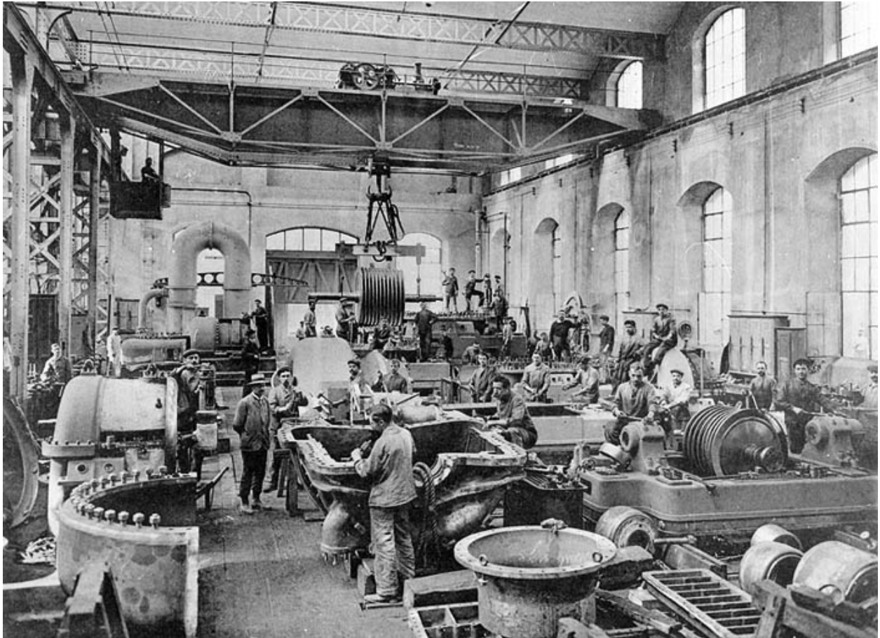
Montage des turbines à vapeur.
