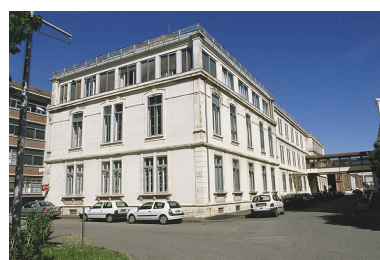
Bureaux depuis l'est. Phot. Jérôme Mongreville IVR43_20029000144ZA
