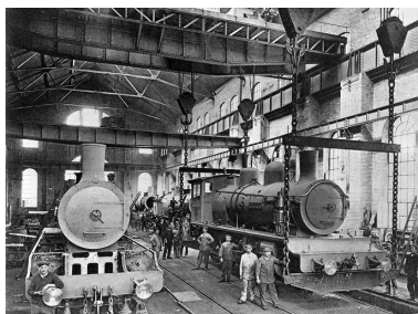
Montage des locomotives. Transport d'une locomotive finie. Phot. Jérôme Mongreville, Autr. Ernest (photographe) Mésière IVR43_20019000143X
