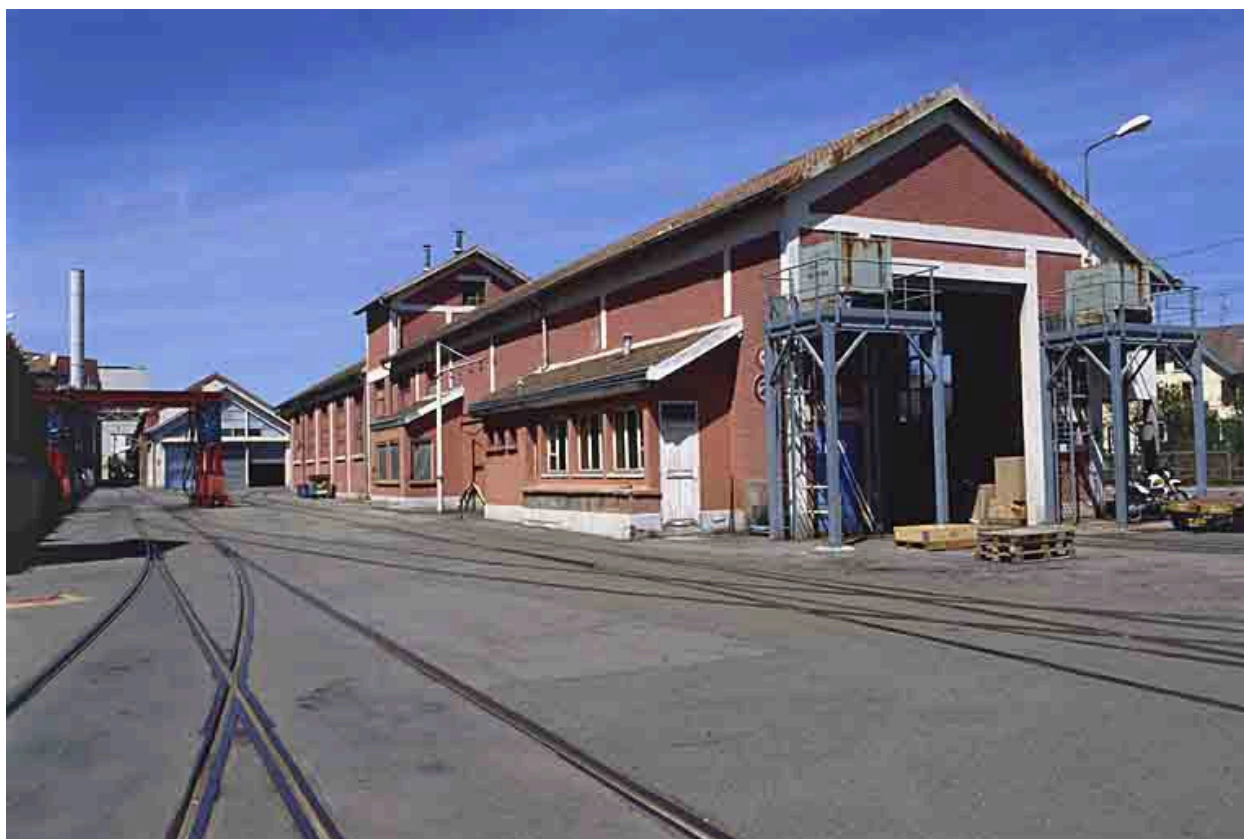
Ancien atelier de peinture des locomotives.
