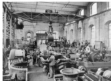
Montage des turbines à vapeur. Phot. Jérôme Mongreville, Autr. Ernest (photographe) Mésière IVR43_20019000141X
