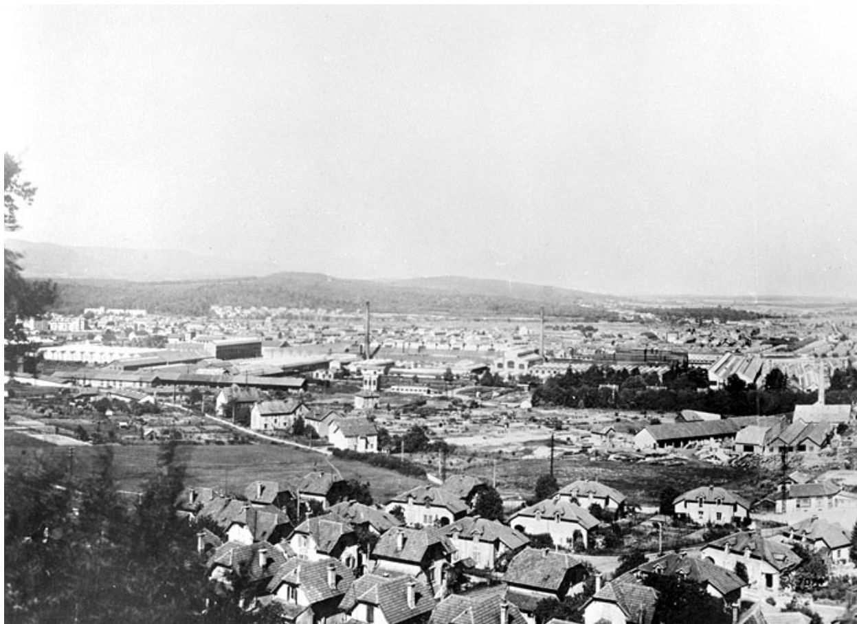
Vue générale des usines de Belfort.
