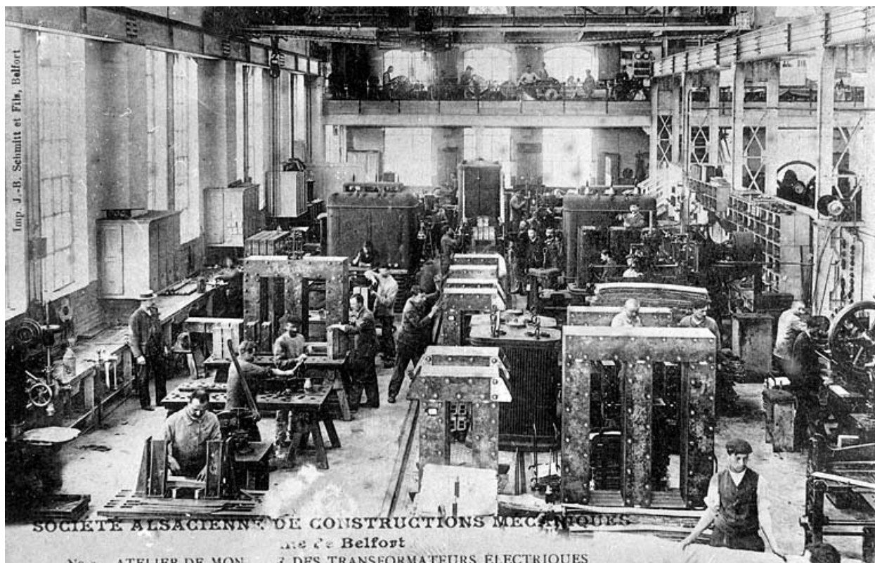
Atelier de montage des transformateurs électriques.
