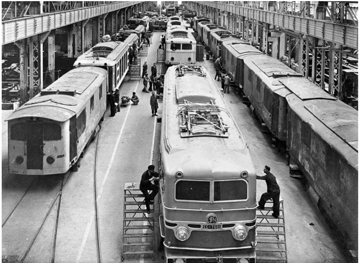
Hall de montage des locomotives électriques.
