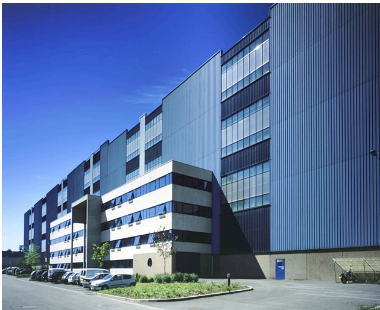
Halle 330 (bureaux et ateliers de montage).
