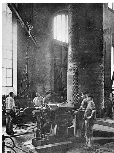
Chaudronnerie - Riveuse hydraulique. Phot. Jérôme Mongreville, Autr. Ernest (photographe) Mésière IVR43_20019000160X
