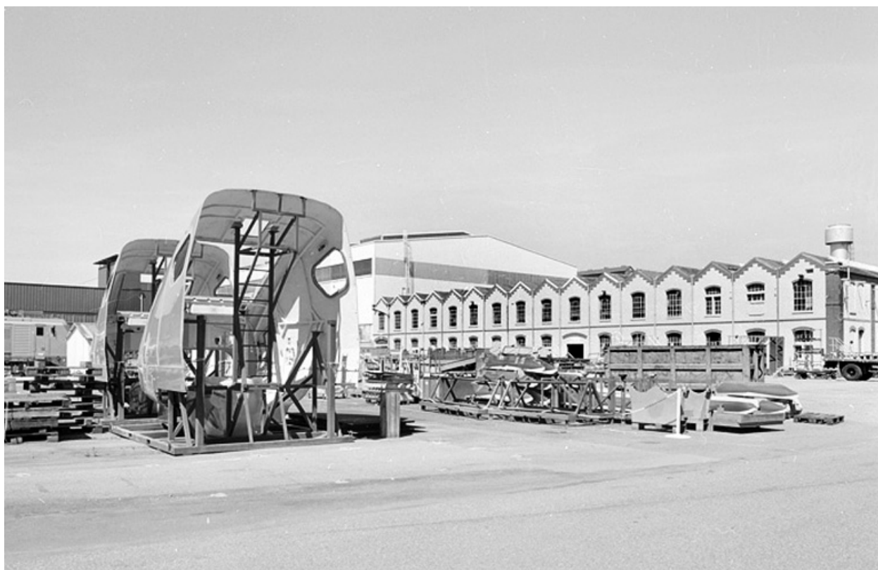
Vue d'ensemble de l'atelier de grosse construction.
