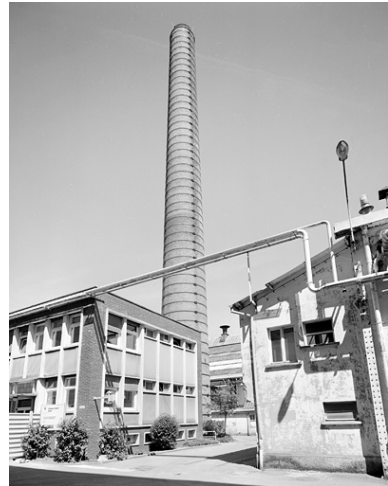
Cheminée. Phot. Jérôme Mongreville IVR43_20029000161V
