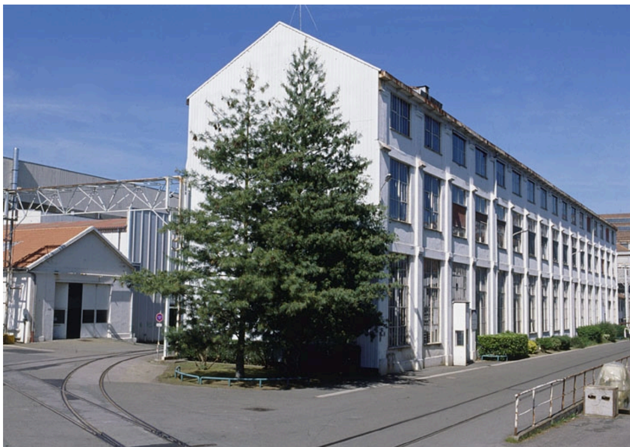
Anciens bureaux des contrôleurs.
