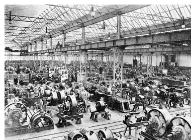
Atelier des dynamos. Autr. auteur inconnu, Phot. Jérôme Mongreville IVR43_20019000083X
