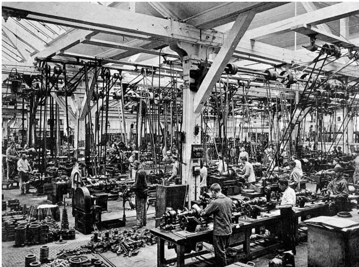
Atelier d'appareillage - Côté machines-outils.
