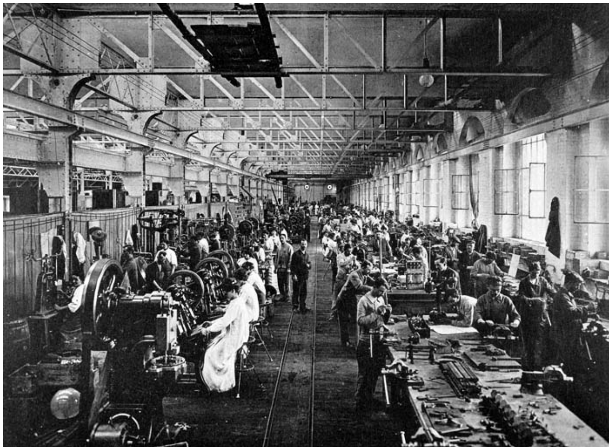
Atelier des petites dynamos - Préparation des enroulements, rhéostats et porte-balais.
