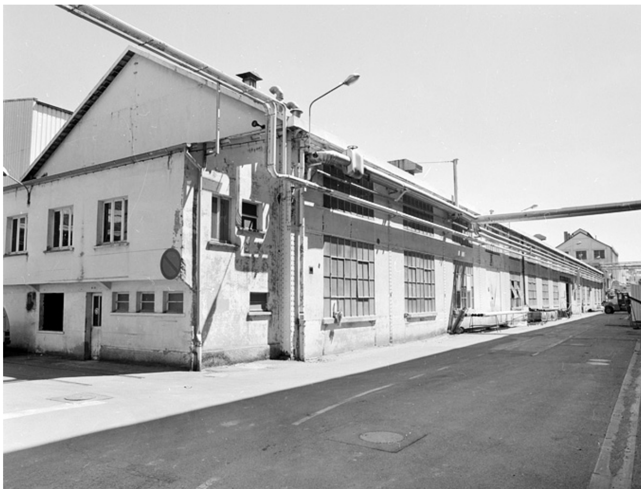
Ancien atelier de petite chaudronnerie.
