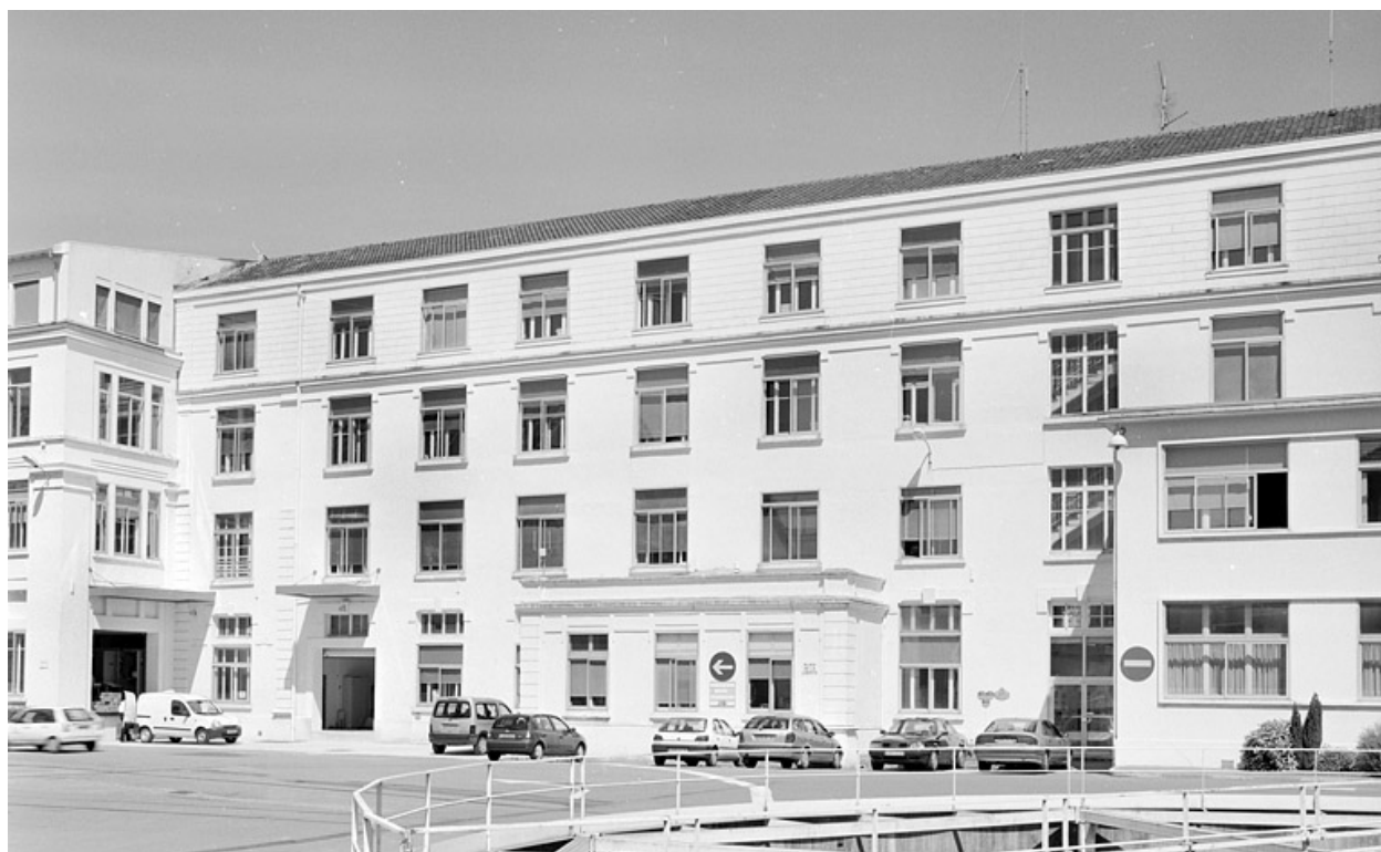
Bureaux et ancienne infirmerie.
