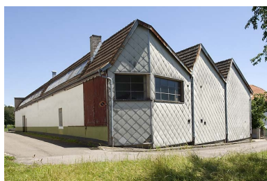
Bâtiments industriels. Vue depuis l'ouest. Phot. Jérôme Mongreville IVR43_20077000397NUCA
