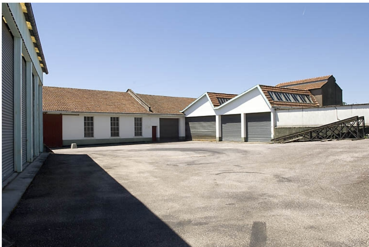
Extension nord de l'usine. Garages.
