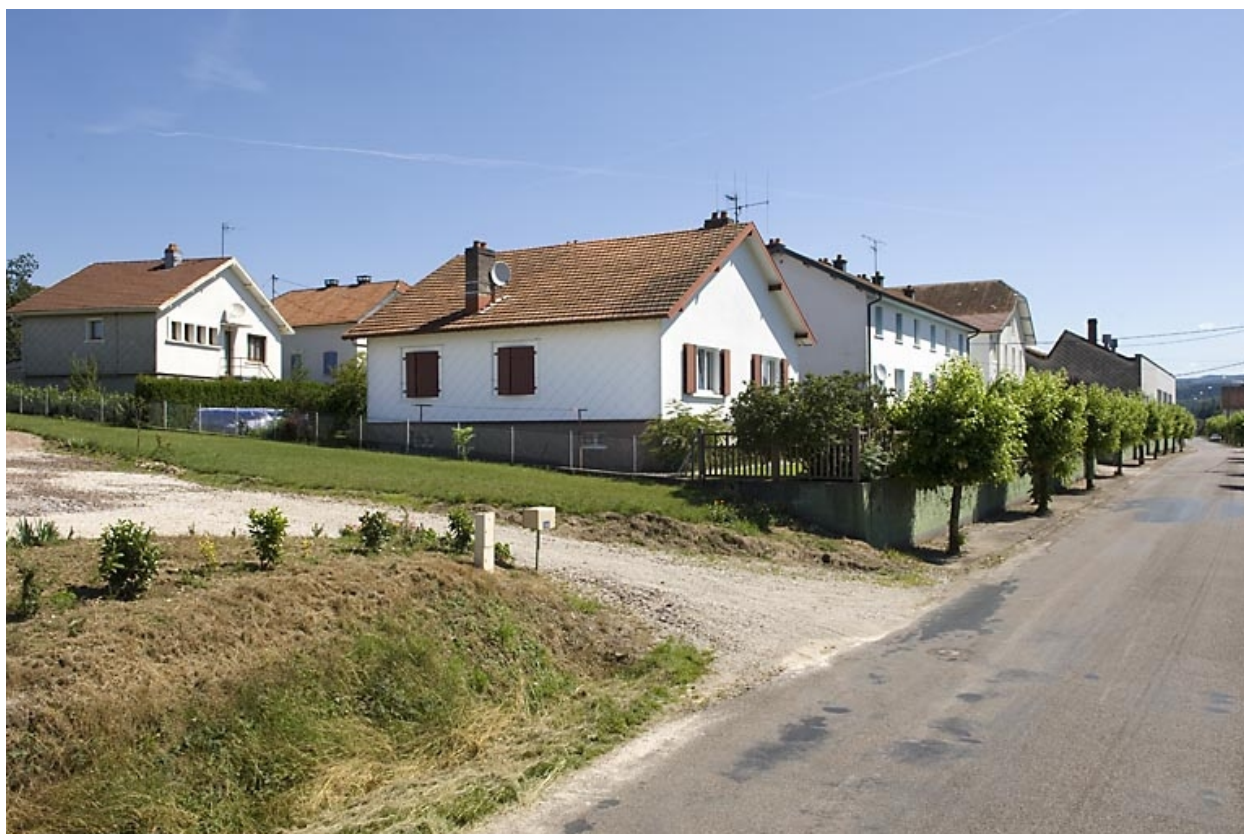
Logements. Vue d'ensemble depuis l'ouest.
