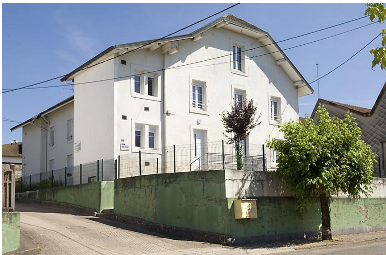
Logement ouvrier collectif.
