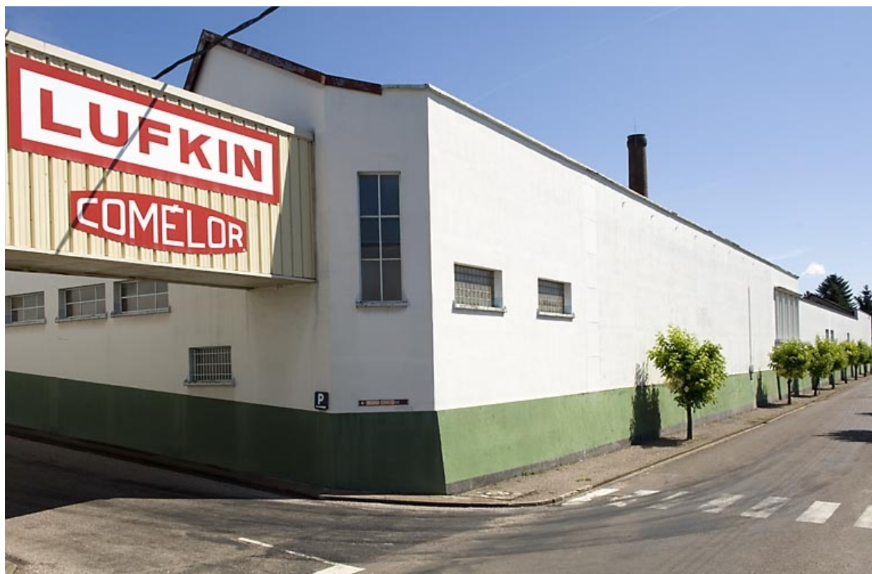
Façade sur rue des ateliers est.
