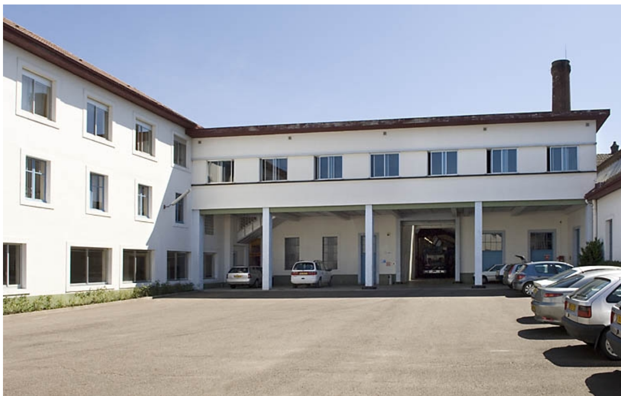
Cour de l'usine. Vue depuis l'ouest.
