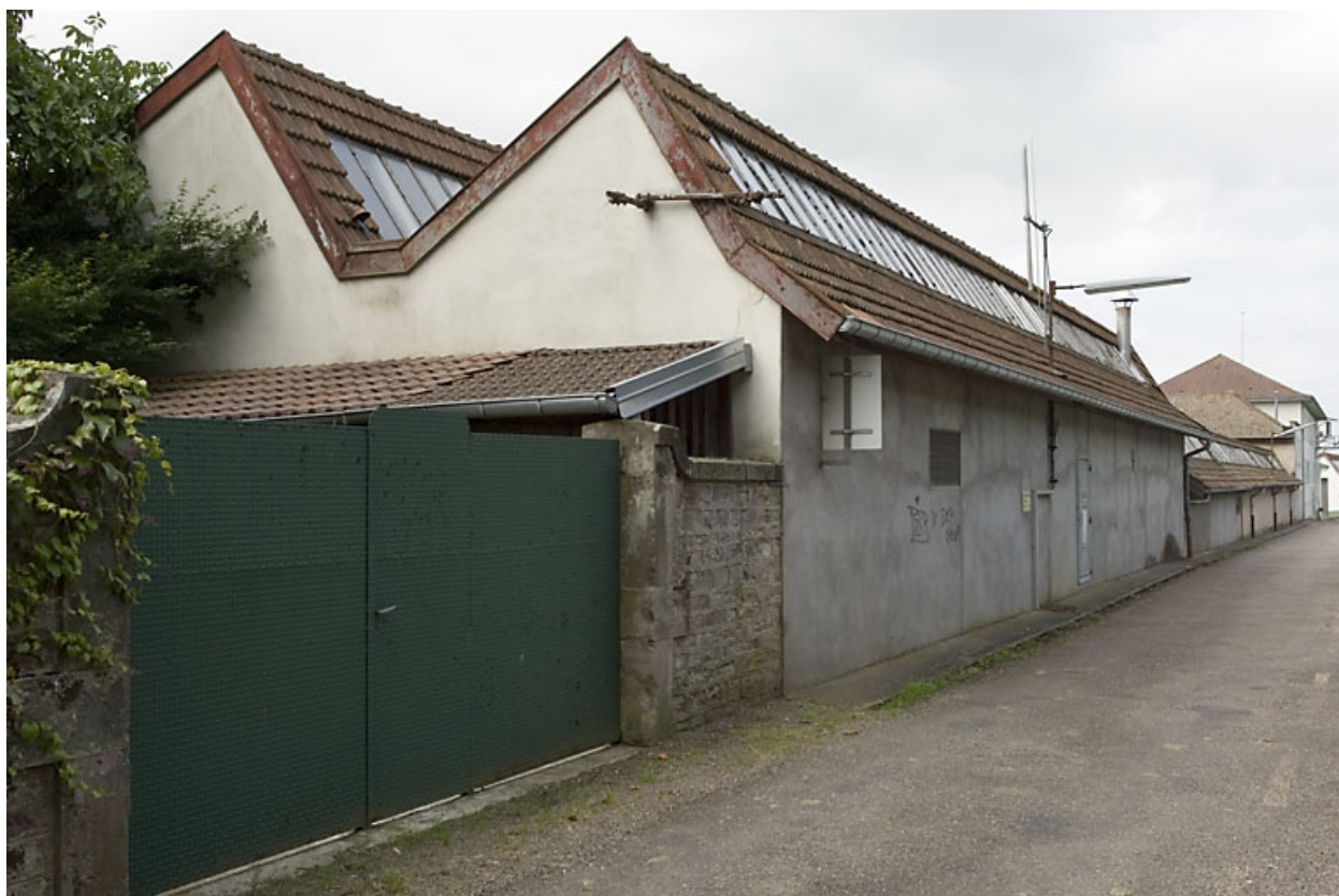
Façade nord de l'atelier de fabrication.
