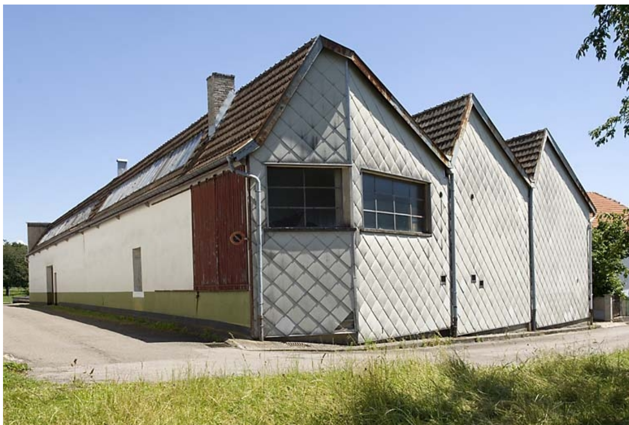
Bâtiments industriels. Vue depuis l'ouest.
