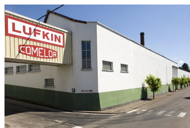
Façade sur rue des ateliers est. Phot. Jérôme Mongreville IVR43_20077000383NUCA
