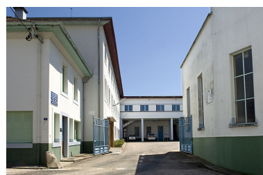
Entrée de l'usine. Phot. Jérôme Mongreville IVR43_20077000390NUCA
