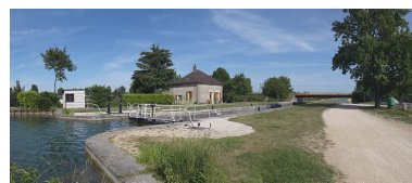
Site d'écluse de 3/4 amont. Vue large. Phot. Thierry Kuntz IVR26_20112102955NUC4A
