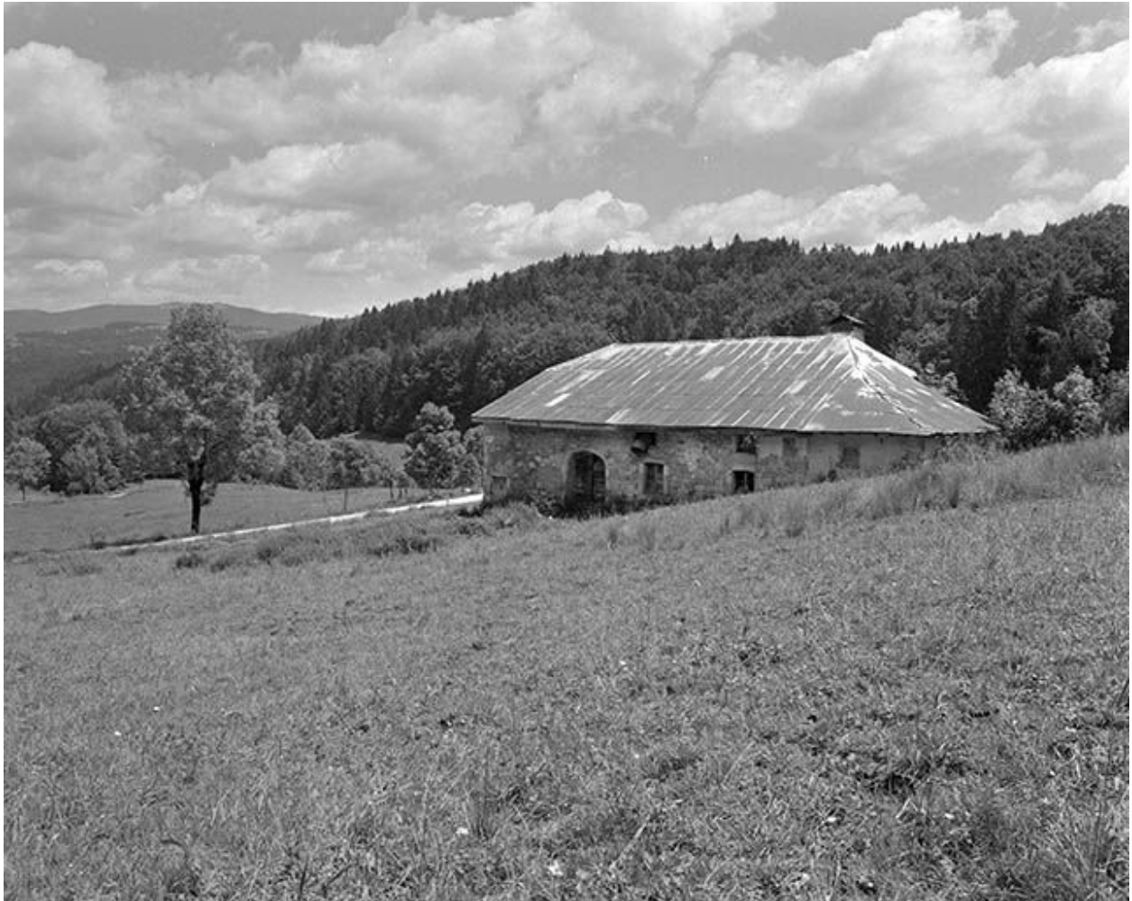
Vue éloignée de la façade postérieure.
